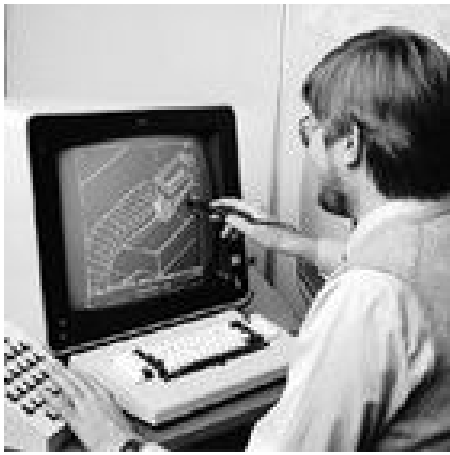
Kuva 8. Cadilla työskentelyä valokynää ja funktionäppäimistöä apuna käyttäen. (Tolsa 17.8.2012)
