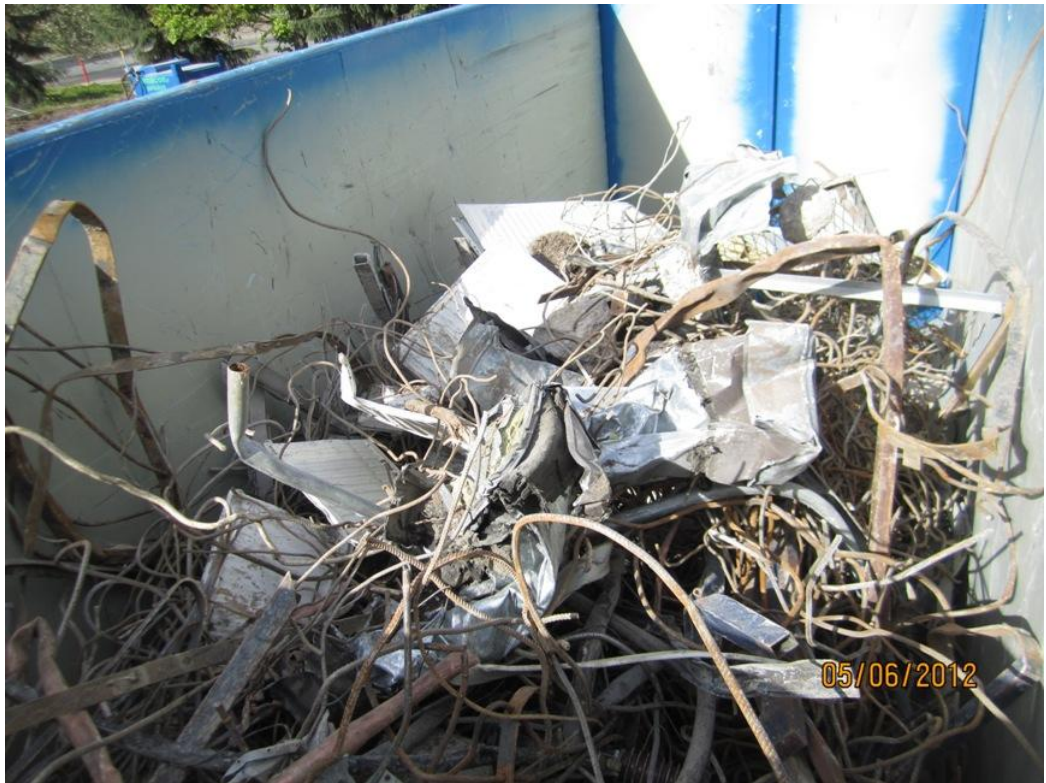
KUVIO 12. Betonirakenteiden purun yhteydessä eroteltua metalliromua
