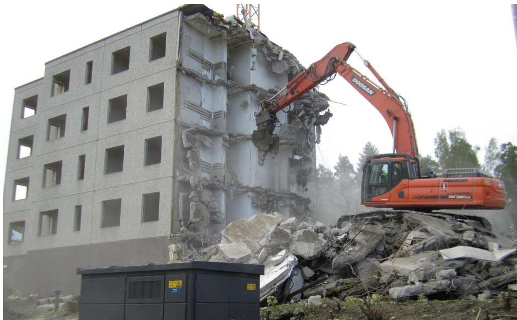
KUVIO 11. Rakennuksen purku kaivinkoneeseen liitetyillä purkusaksilla
