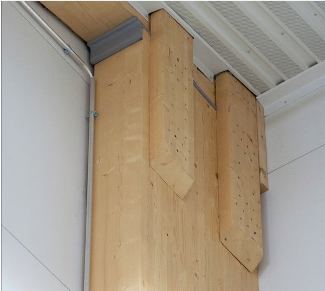
Kuva 6.5 Tukipintaa laajennettu teräslevyllä
