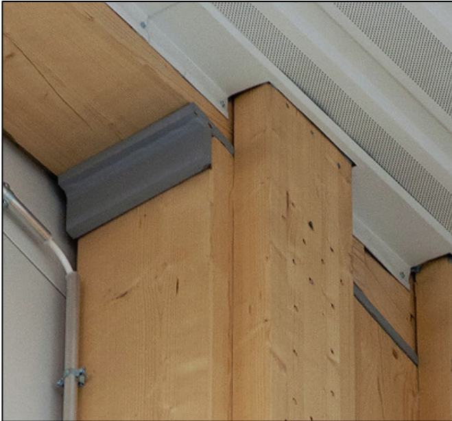
Kuva 2. Tukipinnan laajennus teräsosalla
