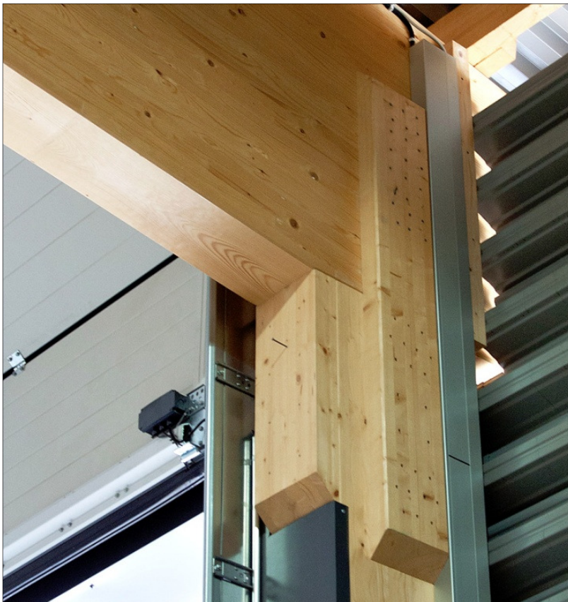
Kuva 6.4. Tukipinnan laajennus liimapuuviisteellä
