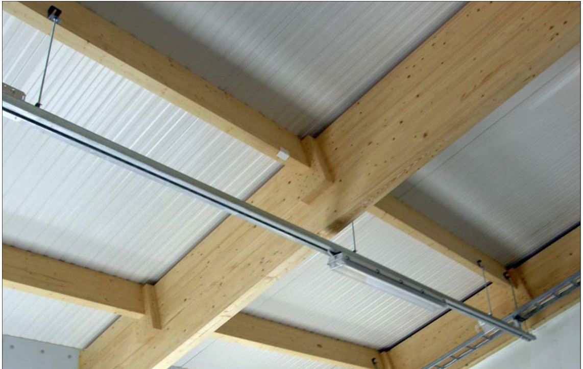
Kuva 8.1. Primääripalkkien sivulle kiinnitettyjä sekundääripalkkeja (13)
