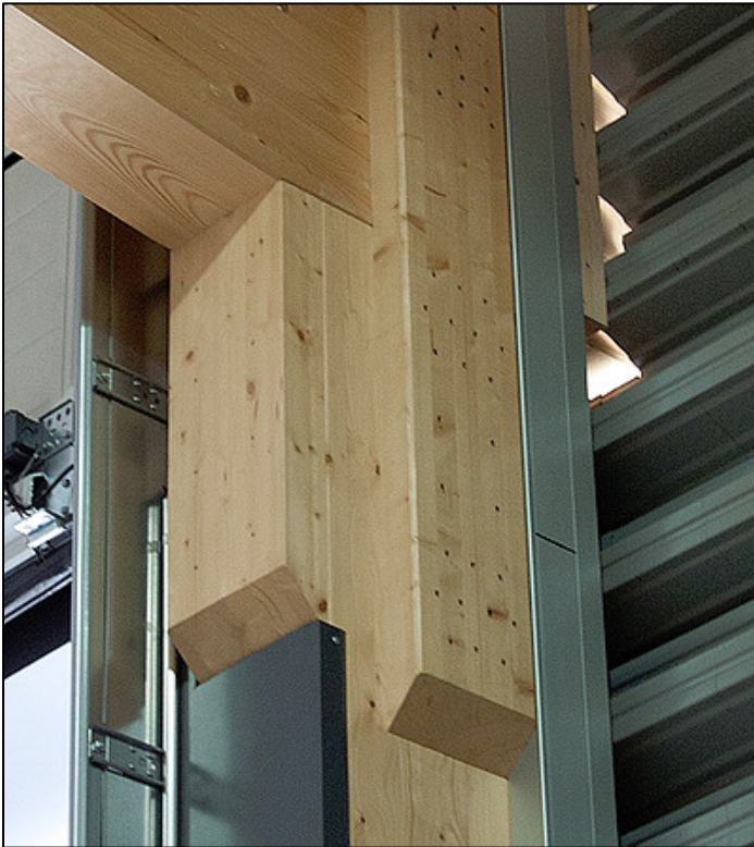
Kuva 1. Tukipinnan laajennus liimapuuviisteellä
