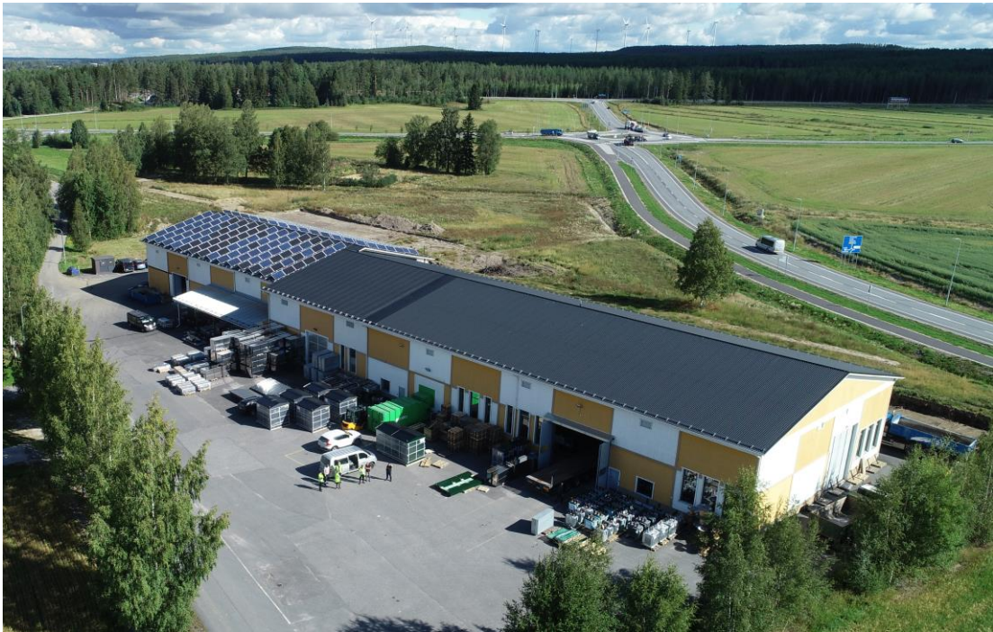
Kuva 1. Harju Elekter Oy:n tehdas Kurikassa. /3/
