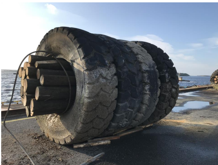
Kuva 7. RMC Varustelulaiturin Törmäyssuoja (Veini Arponeva 2020).
