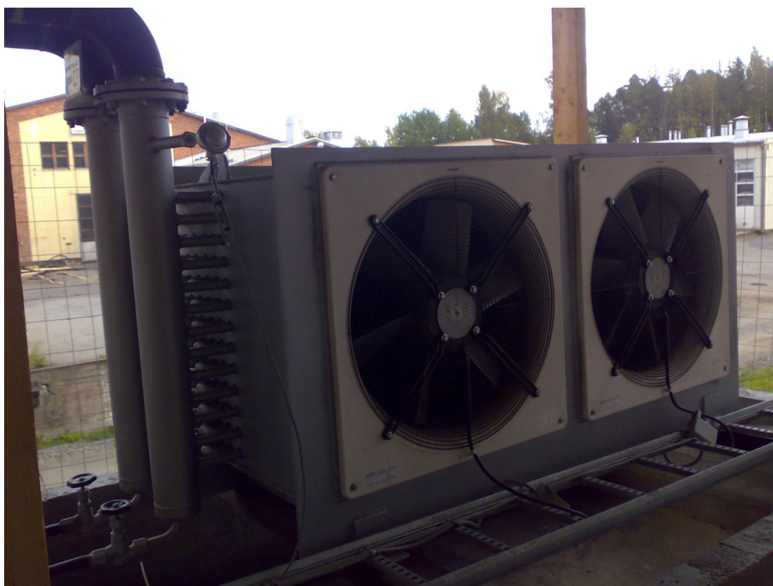
Kuva 10, SWM-Woodin kattilalaitoksen 1MW ulkojäähdytin(Järvelä 2009)
