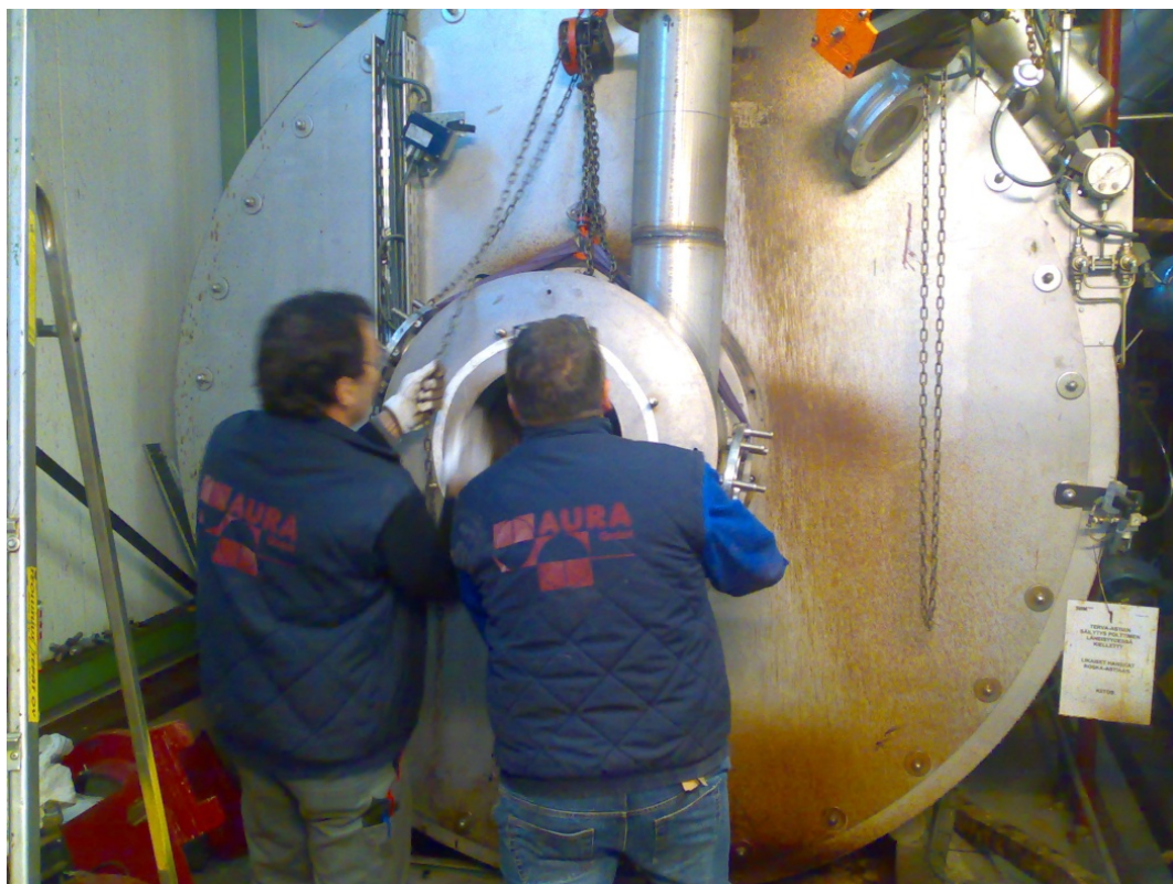
Kuva 11, uuden, haponkestävän päästöjenpolton syöttöosan asennus (Järvelä 2009)
