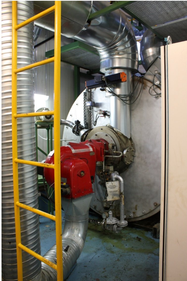
Kuva 5, SWM-woodin 2MW:n kombikattila vm.2008(Järvelä 2010)
