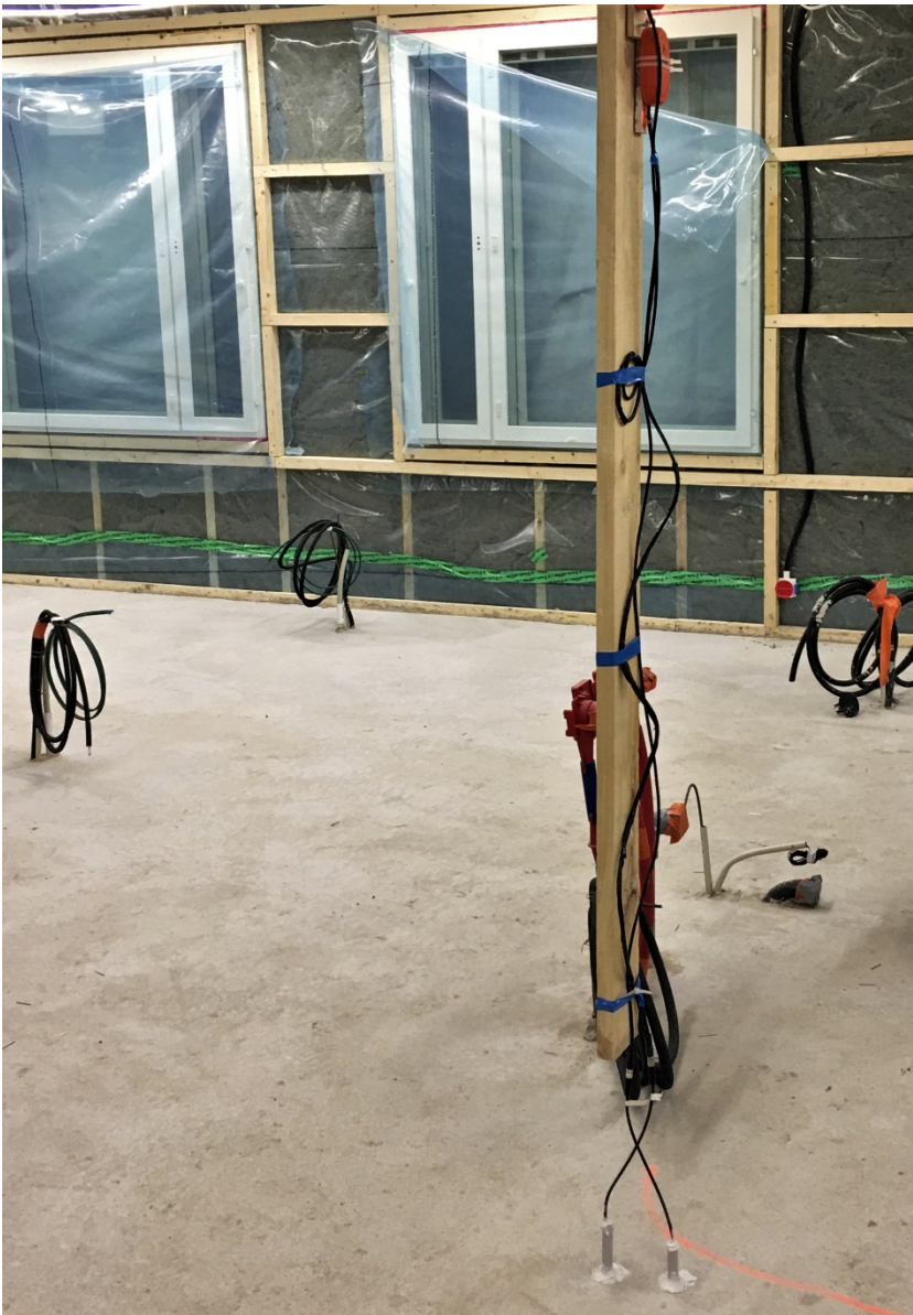
KUVA 1. Mittausanturit betonilaatassa OSAOn rakennuskohteessa (kuva: Sanna Alitalo)
