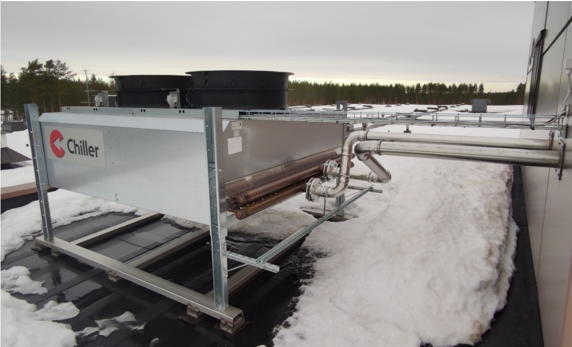
Kuva 15. Vedenjäähdytyskoneen lauhdutinpiirin nestejäähdytin.
