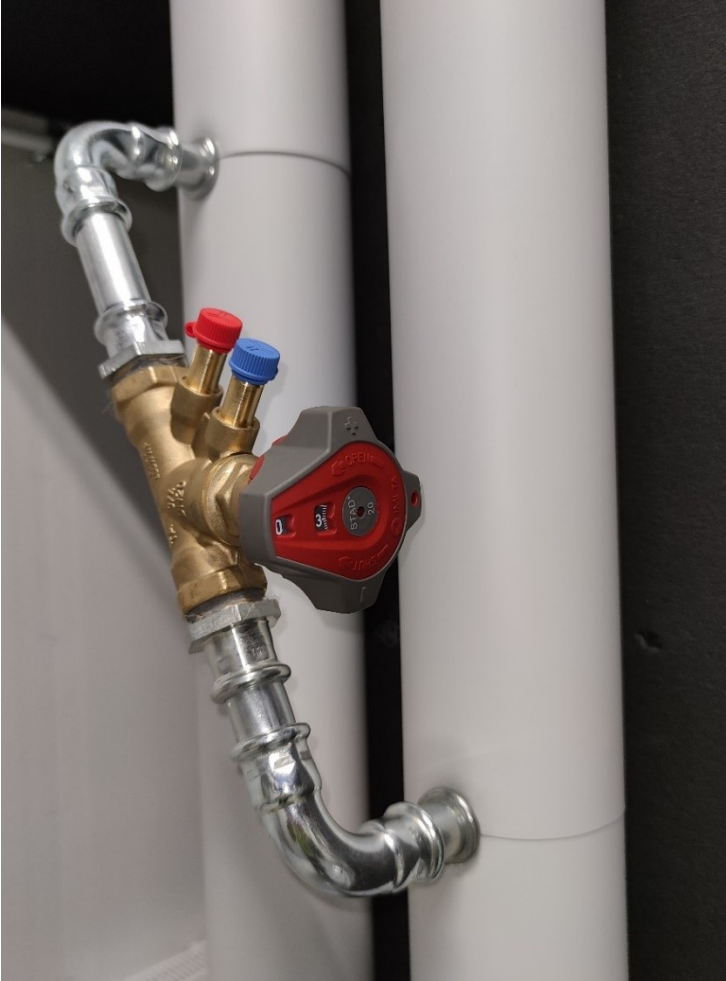
Kuva 5. IMI TA STAD linjasäätöventtiili.
