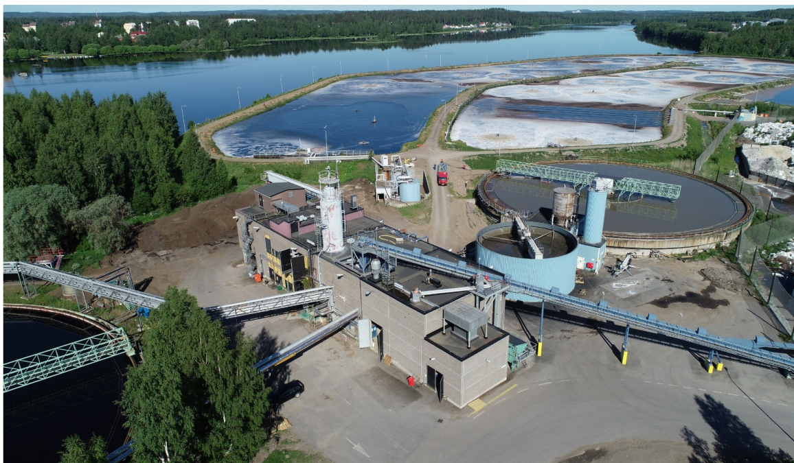
KUVA 1. Stora Enso Varkauden tehtaan jätevedenpuhdistamo (Thil 2019)
