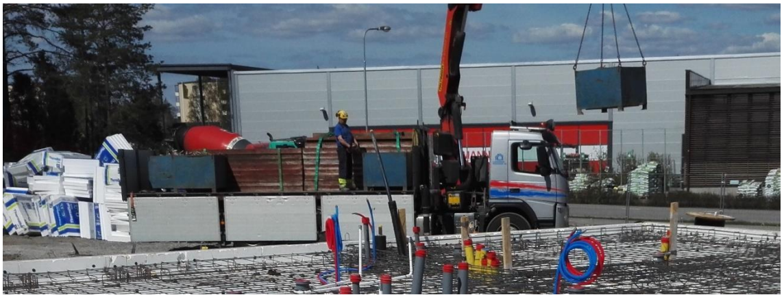
Kuva 3. HIAB-käytössä (Ojarannan Rakennus Oy).
