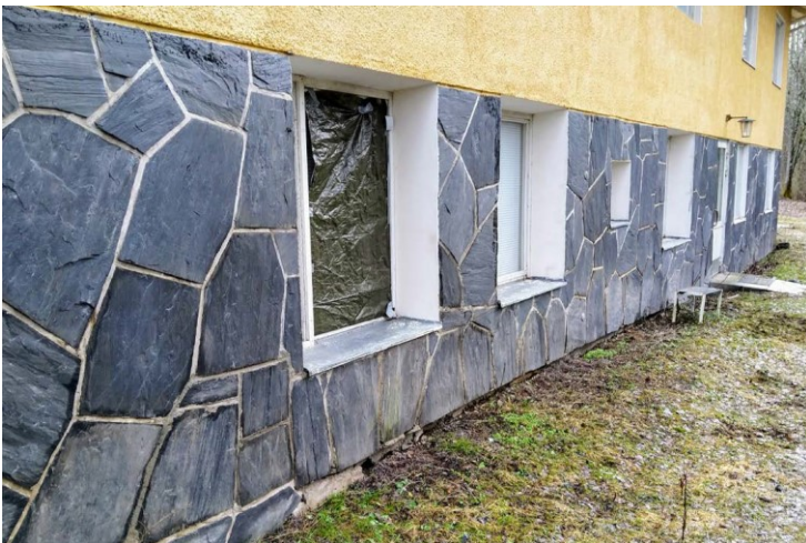
Kuva 3. Sokkelin liuskekivipäällyste (valokuva Markku Raimovaara 12.2.2020)
