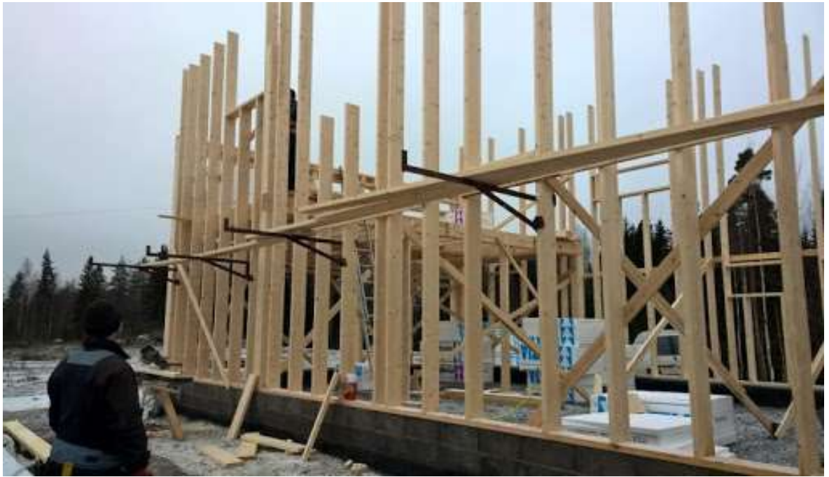
Kuva 2. Paikalla rakennettu ulkoseinärunko.
