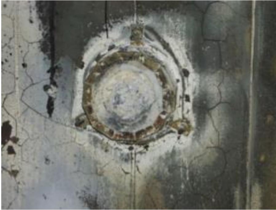
Kuva 5. Testissä käytetty palokatkomansetti ja muovinen putkiläpivienti.
