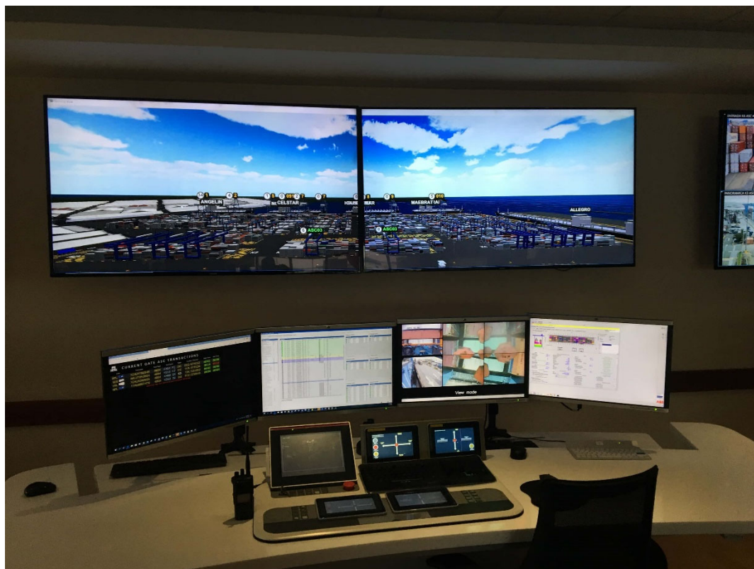
Kuva 11. Automatisoitujen siltanostureiden valvontahuone ja virtuaalinen näkymä koko konttikentästä (Notteboom, Pallis & Rodrigue 2020).
