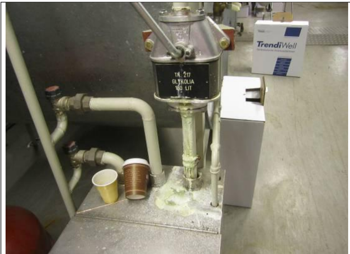
Kuva 13. 217 TK:n glykoliverkoston täyttöpumppu vuotaa.
