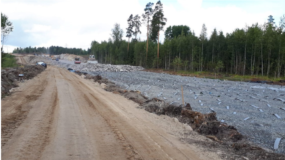
Kuva 23. Esikuormituspenger louheesta pystysalaojakentällä 4. Kuvassa näkyy myös maahan asennettujen pystysalaojanauhojen päät.
