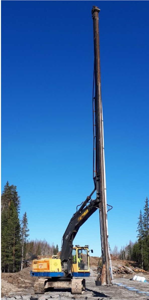
Kuva 21. Klaukkalan ohikulkutiellä käytetty pystysalaojakone.
