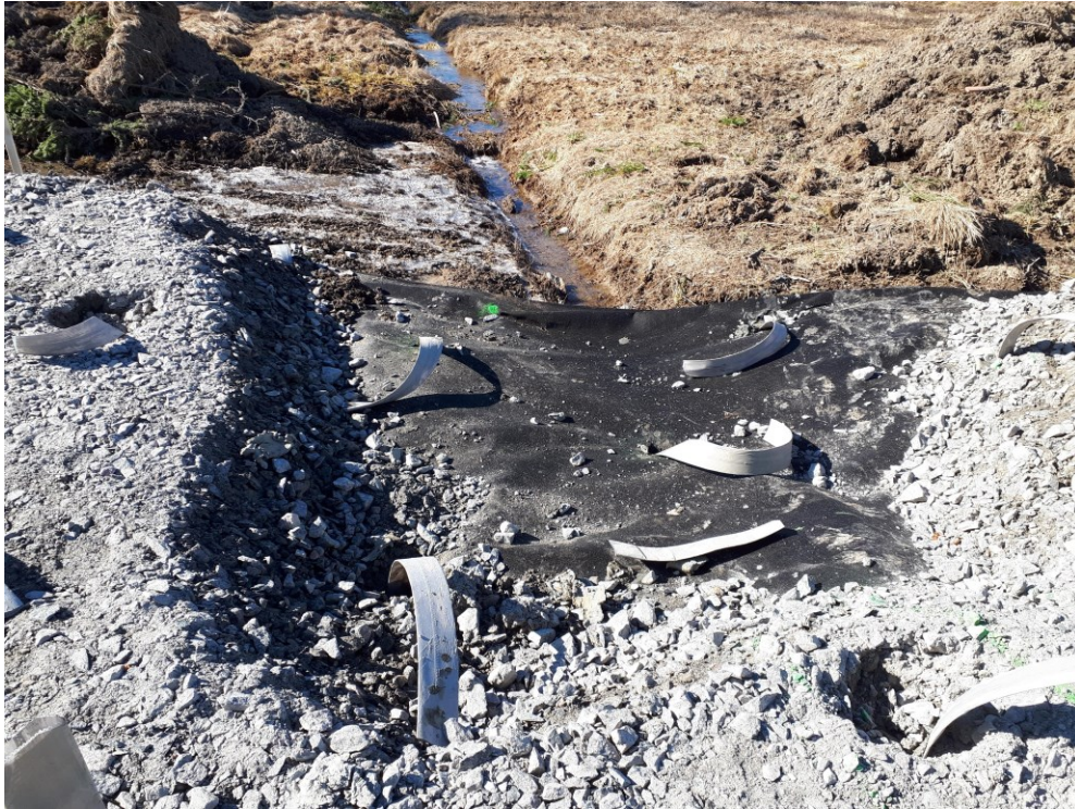
Kuva 19. Pystysalaojakentän ojituskerros ja purkuoja.
