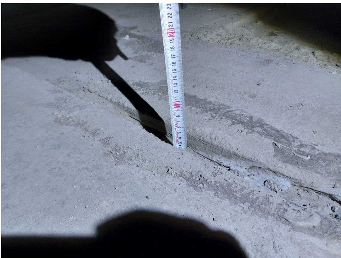
Kuva 17. Vajaaksi valettu ontelolaattojen sauma
