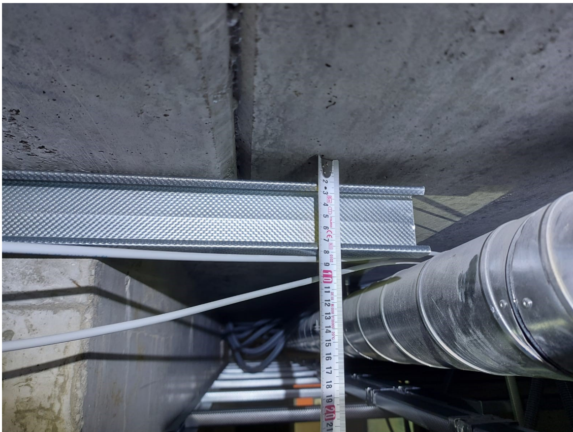
Kuva 15. Hammastus eripituisten ontelolaattojen välillä
