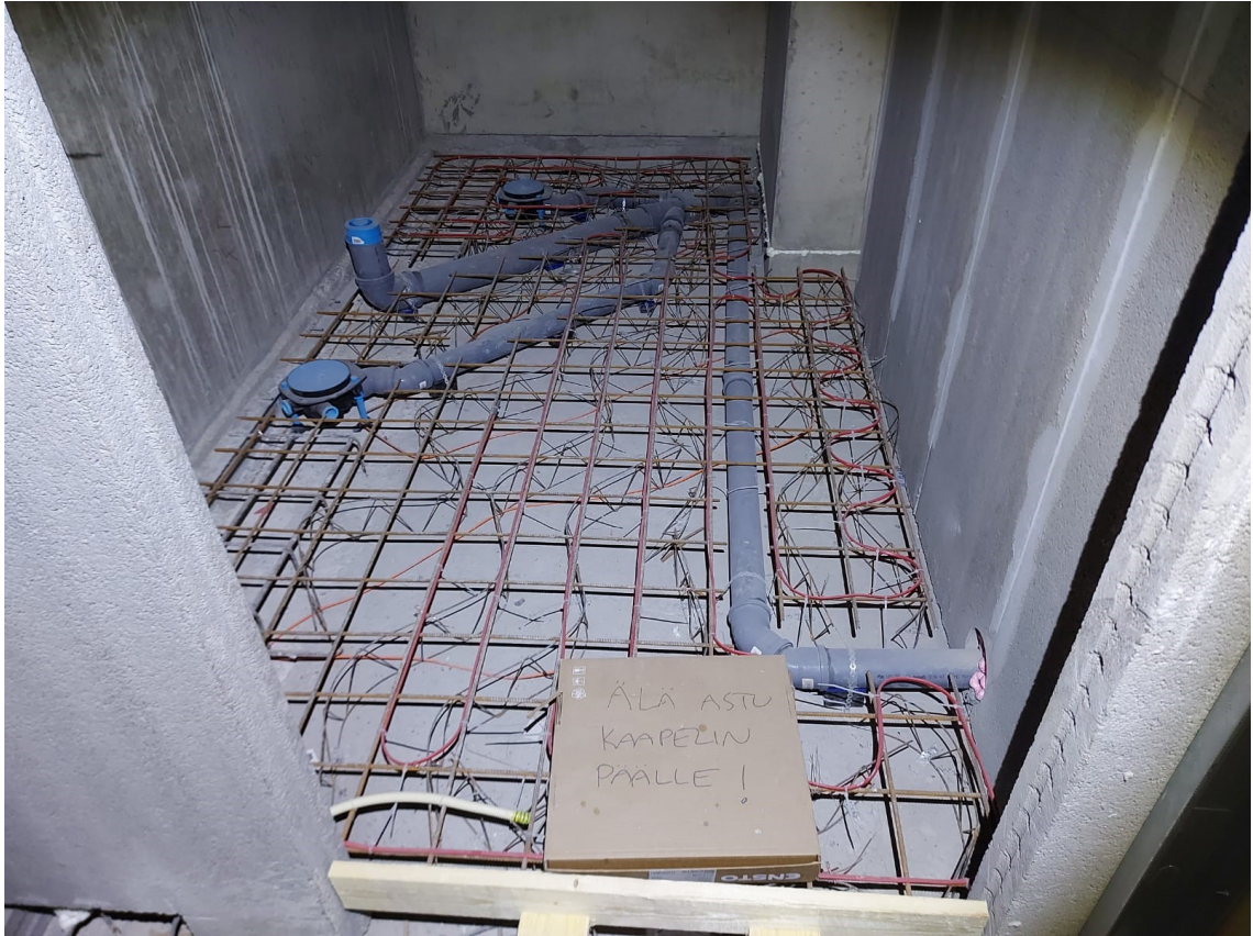
Kuva 8. Valamaton kylpyhuoneen kaatolattiavaraus
