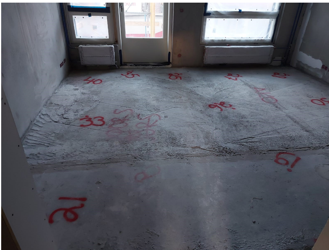
Kuva 14. Matalaksi jäänyt ulokeparvekkeen ankkurointivalu, ei kuitenkaan tekstin esimerkki työmaalta.
