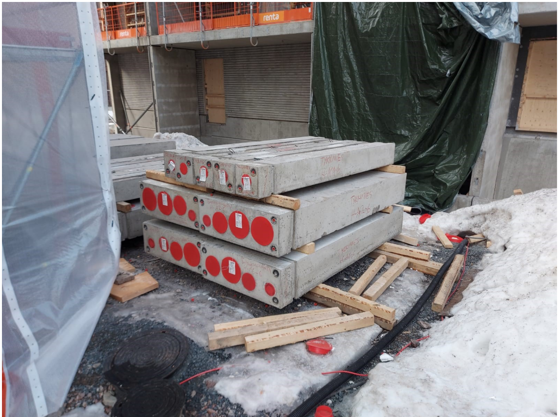
Kuva 3. Hormielementtejä työmaalla varastoituna
