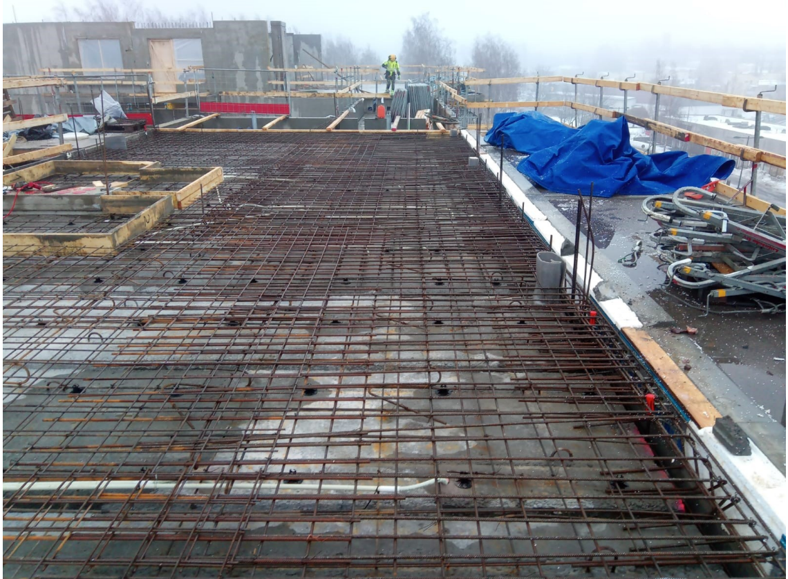
Kuva 7. Ulokeparvekkeen ankkuriraidoitukset
