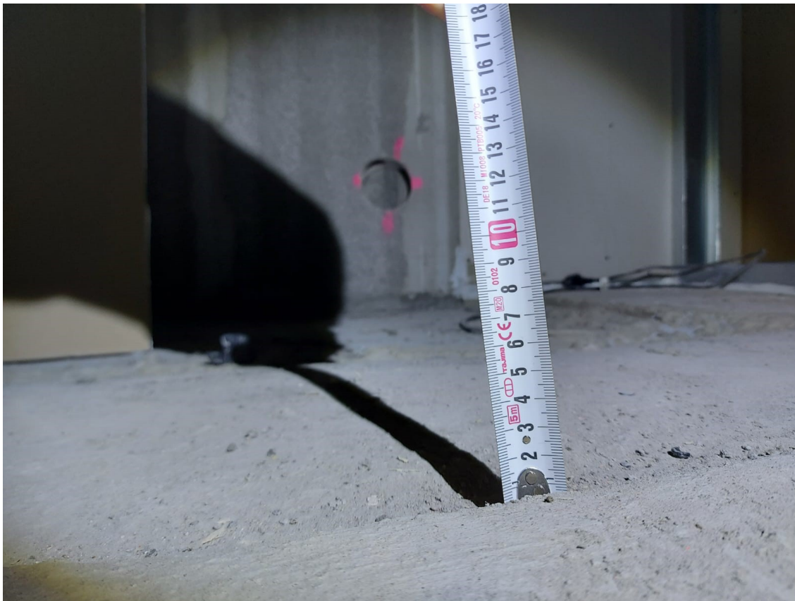
Kuva 12. Hammastus toisistaan poikkeavien elementtien välillä
