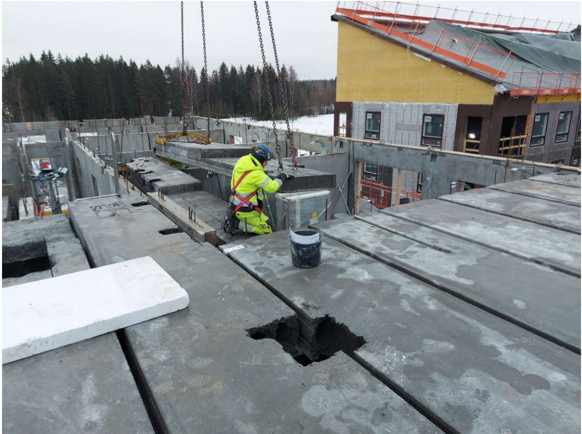
Kuva 6. Ontelolaatan asennus
