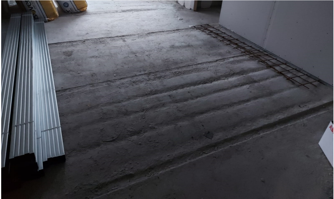
Kuva 5. Pinnasta aaltoileva elementti
