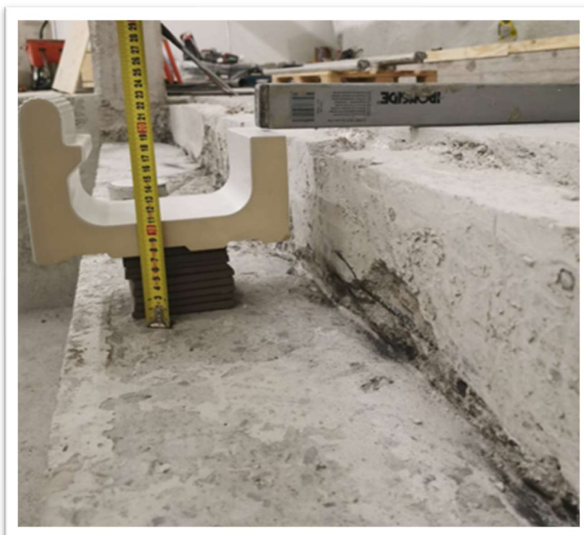
Kuva 18. Uusien loiskekourujen korko verrattuna vanhoihin. Altaaseen tehtiin rakenteellinen korjaus, jotta uudet kourut saatiin oikeaan tasoon.
