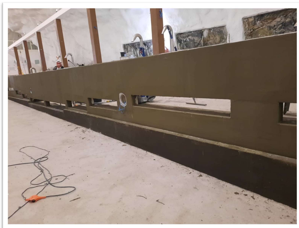
Kuva 22. Altaan seinään asennettu Mapelastic-vedeneristelaasti kahdessa kerroksessa, jonka välissä on lasikuituverkkovahviste.
