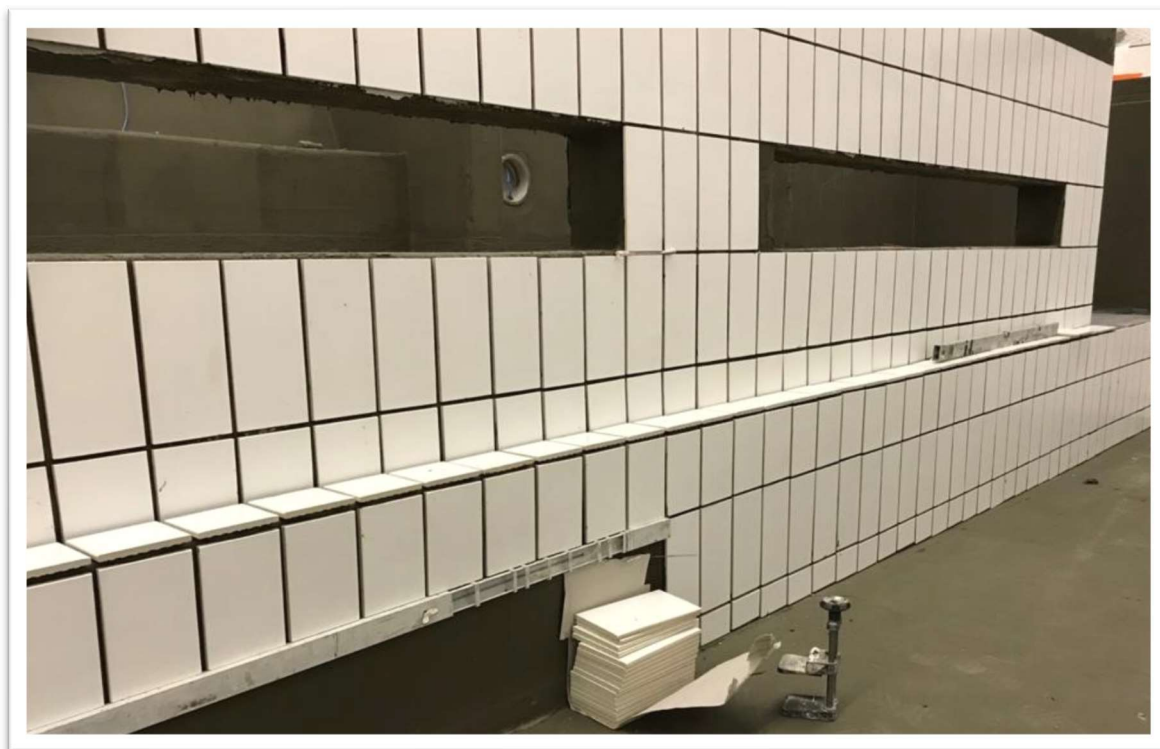
Kuva 23. Altaan seinän laatoitus märkäpuristelaatalla 115 x 250, jonka saumakoko 7 mm.
