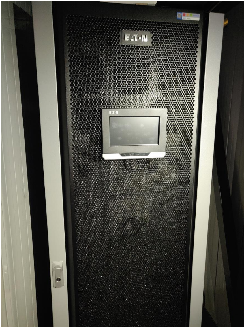
KUVA 8. Oamkin UPS-laitte superkondensaattorikennostolla
