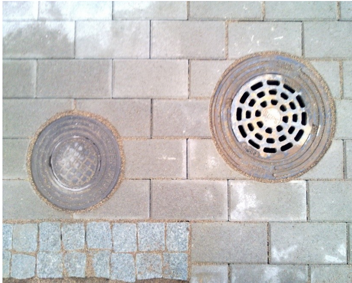
KANSISTOIHIN RAJAUTUVIEN BETONIKIVIEN SAUMAT SAHATTU TASALEVEIKSI.
