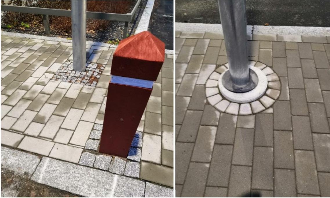
KUVA 9. Valaisintolppien juuren kaksi erilaista asennustapaa
