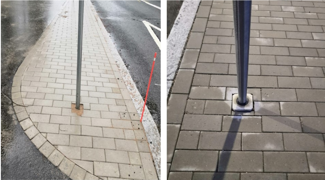
KUVA 8. Liikennemerkkien asennusjalustojen upotukset
