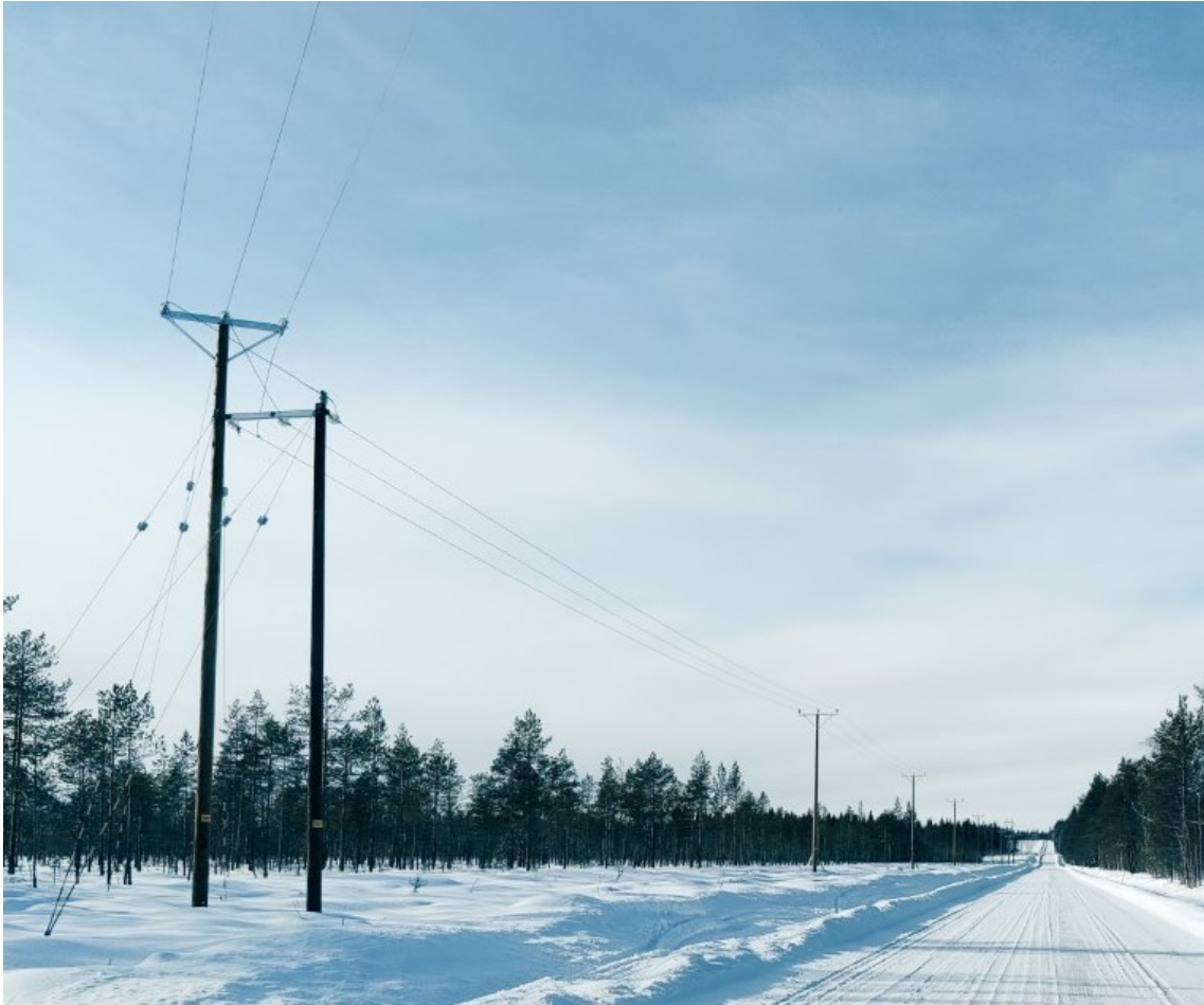
KUVA 12. Uusi keskijänniteilmalinja tien varrella
