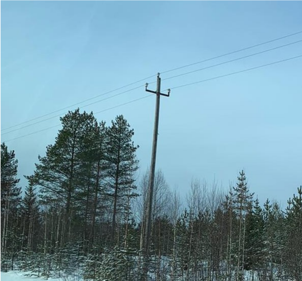
KUVA 11. Orsirakenteinen keskijänniteilmalinja
