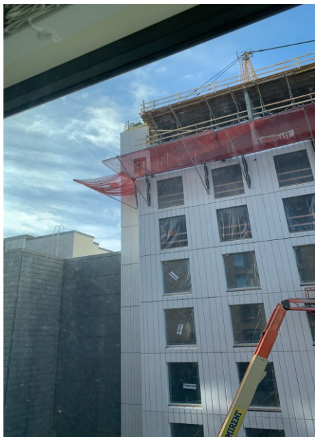
Kuva 4. Putoamissuojaverkko asennettuna rakennustyömaalla.
