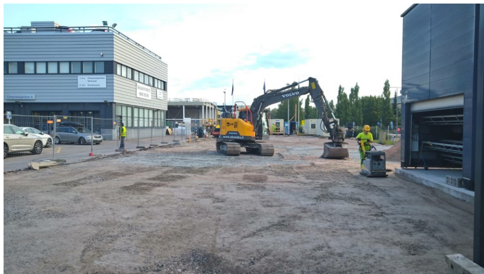
Kuva 17. STM Infran työmaalla Olarissa kaivinkoneella voidaan koneohjausta hyödyntämällä tasoittaa suoraan oikeaan kuvien mukaiseen korkoon.
