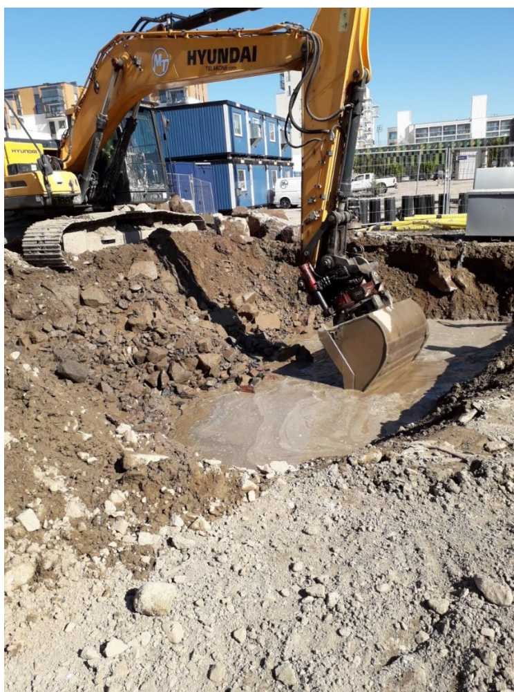
KUVA 16 Maarakennuksen aikana ilmennyt vettä läpäisevä maakerros (Kettunen).
