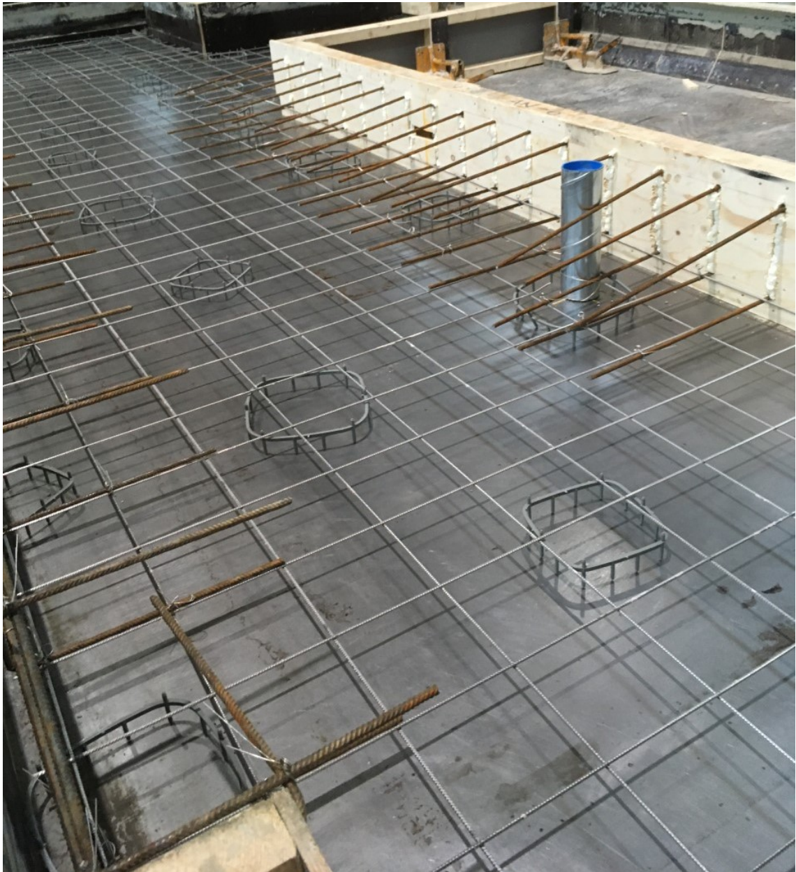
KUVA 2. Betonisandwich-elementin valmistusta Suoraman Elementin tehtaalla Lempäälässä.
