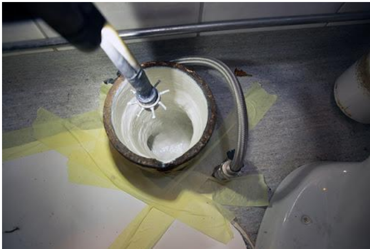
Kuva 7. Ruiskuvalumenetelmässä käytetty työkalu /18/
