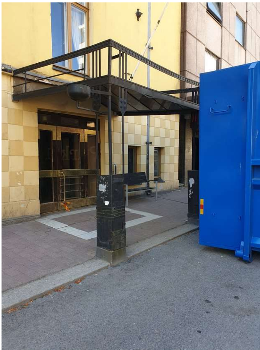
Kuva 8. Pääsisäänkäynnin katos (Julia Gljakova).
