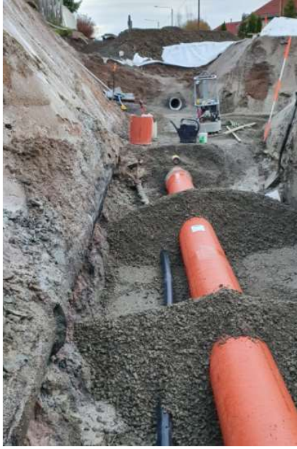
Kuva 27 Putkikaivanto, oikealla vesijohto, keskellä jätevesi ja oikeassa ylänurkassa valmistuu hulevesiviemäri
