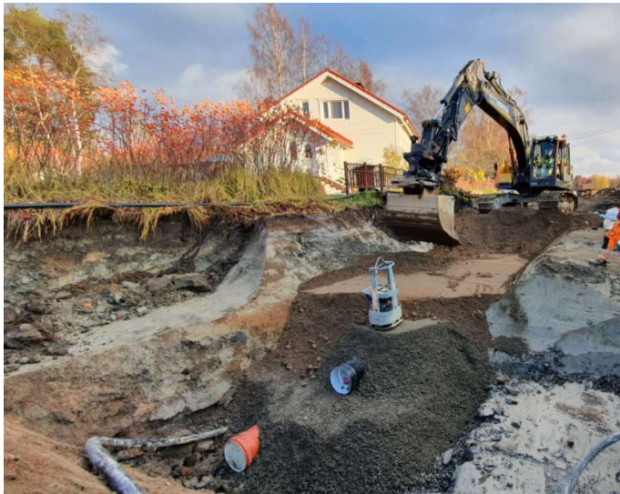
Kuva 28 Täyttövaiheessa oleva putkikaivanto. Alimpana vesijohto, keskellä jätevesiviemäri ja ylimpänä hulevesiviemäri
