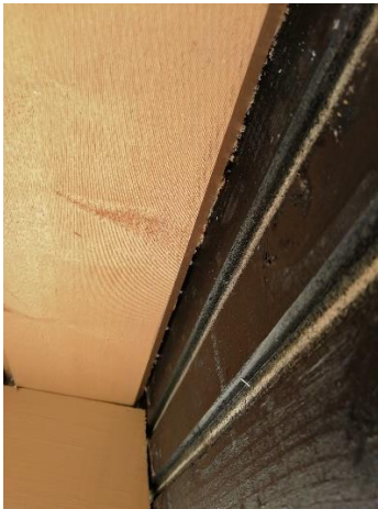
Kuva 6. Räystäslauta tuotu kiinni julkisivupaneeliin.
