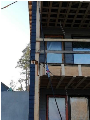
Kuva 7. Toisen kerroksen puuelementti vinossa.
