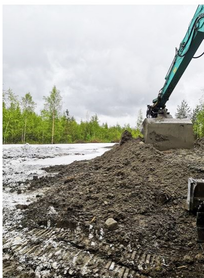
KUVAT 5-7. Vasemmalla näytteiden ottoa ylijäämämaasta 8.5.2019 Oulun Korvenkylässä (kuva: Laura Sihvonen), keskellä maamassan levitystä Välilimaalla (kuva: Venla Honkala) ja oikealla maamassojen levitystä kaivinkoneella. Vesisateiden vuoksi maa-aines oli hyvin upottavaa (kuva: Laura Sihvonen)
