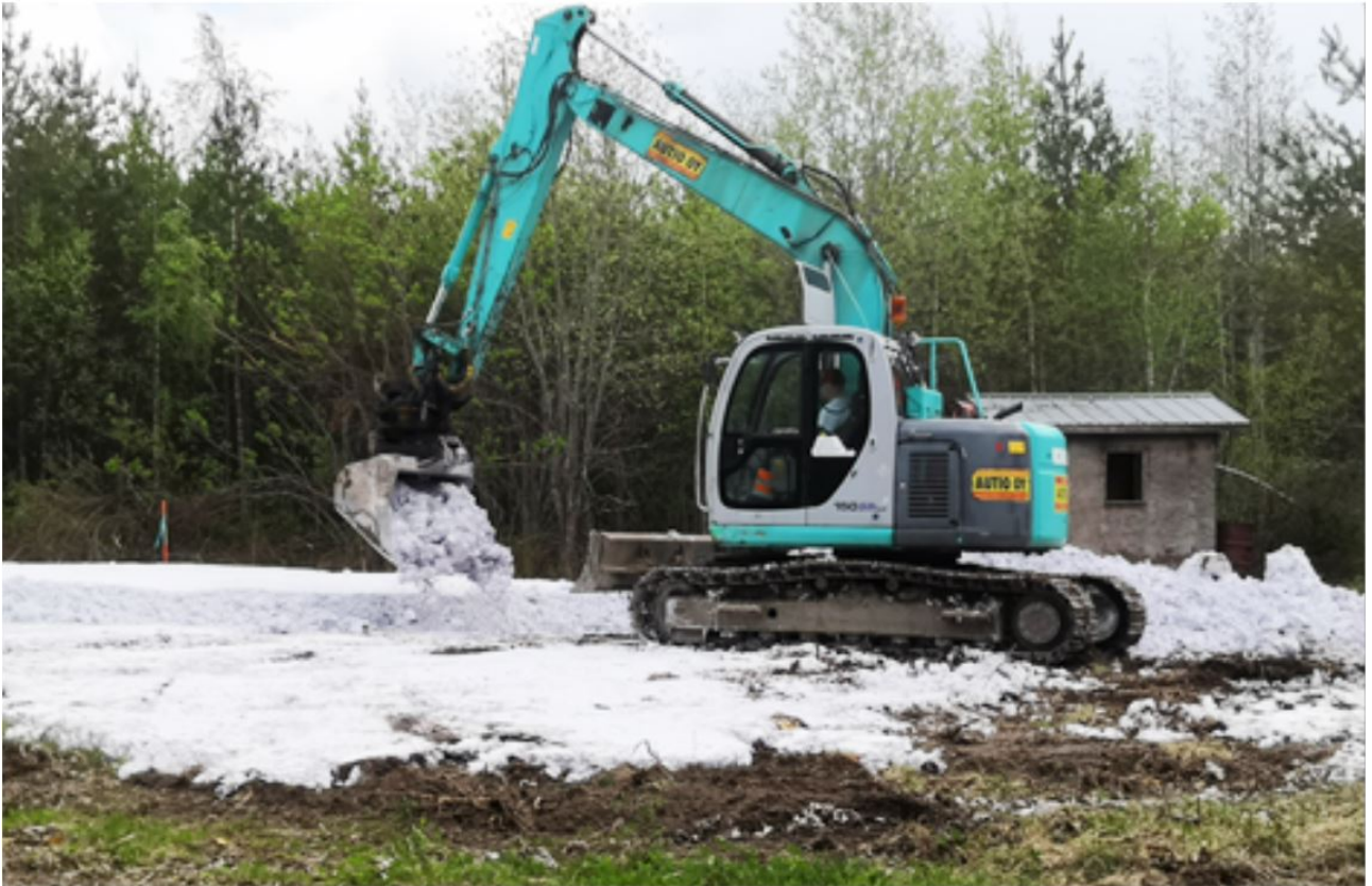
KUVA 4. Opasakan levitystä (kuva: Laura Sihvonen)
