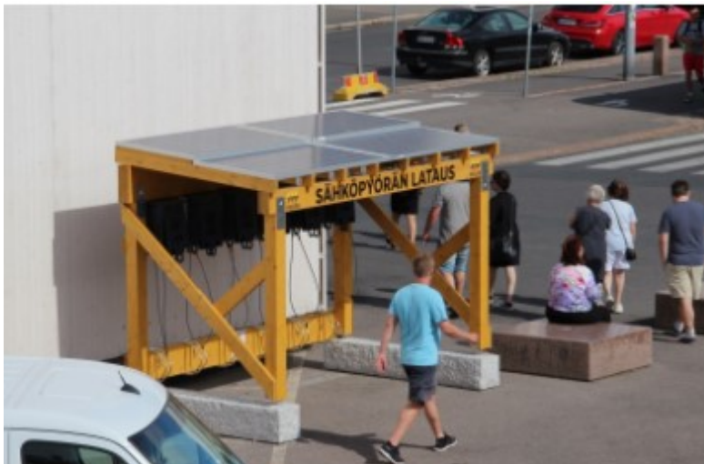
Kuva 19. Helenin omavarainen sähköpyörän latausasema (29).
