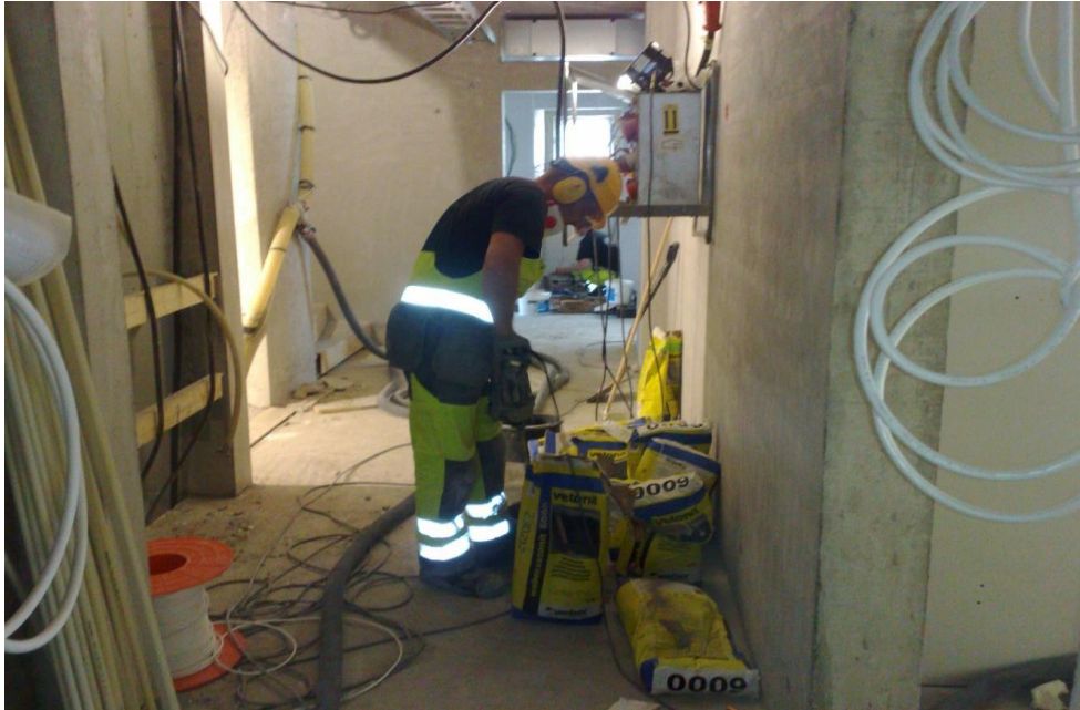
Kuva 8 Tasoitteen sekoittamista kerrostaalla
