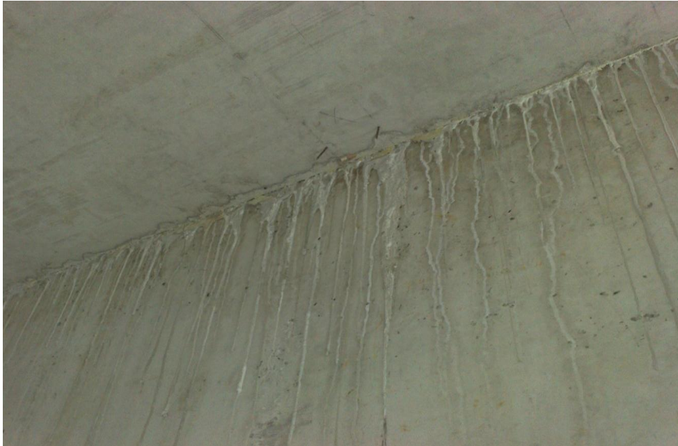
Kuva 5 Karkeapuhdistusta vaativa betoniseinä
