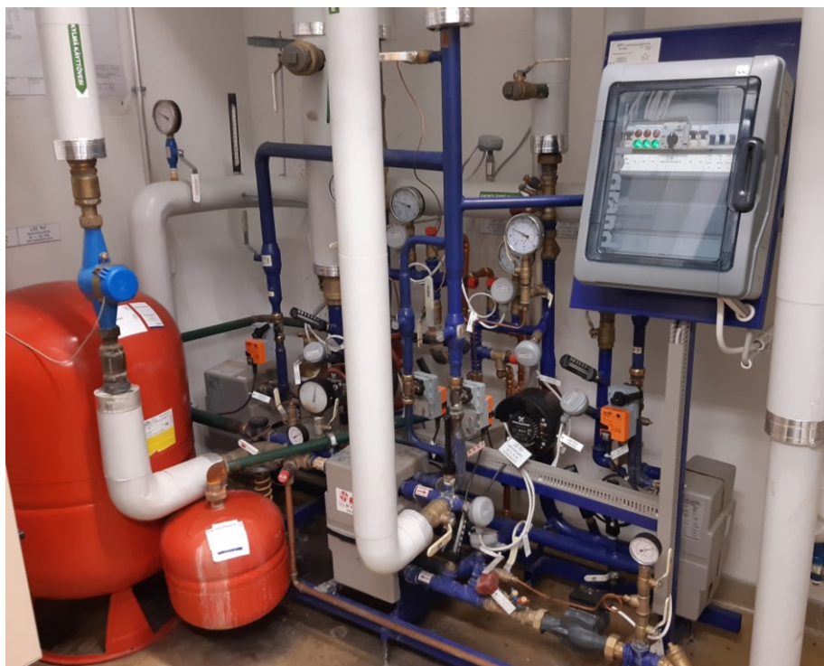
Kuva 5. Kiinteistön lämmönjakolaitteisto
