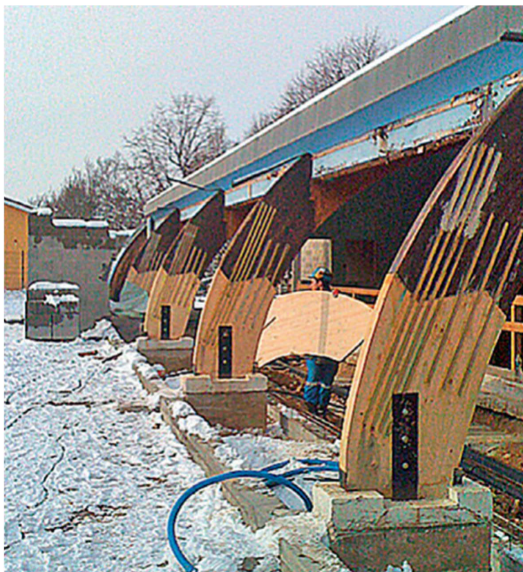
Kuva 26. Foreva Wood, proteesikorjaus. (Freyssinet Group)
