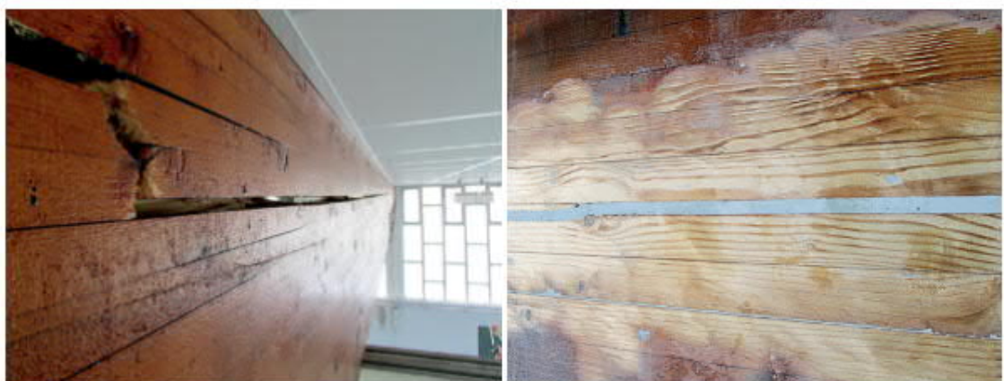
Kuva 32. Epoksi-injektiokorjaus, (Strengthening of glue-laminated timber structures, Freyssinet Group)
