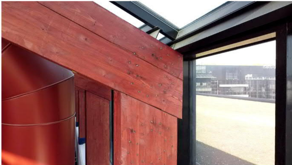
Kuva 16. Halkeillut BSB-liitos (Nodetec Oy)
