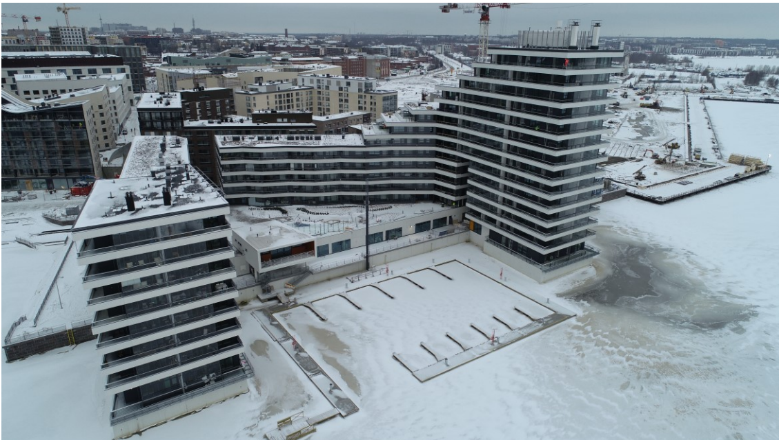
Kuva 11: Kuvassa tutkittava työmaa
