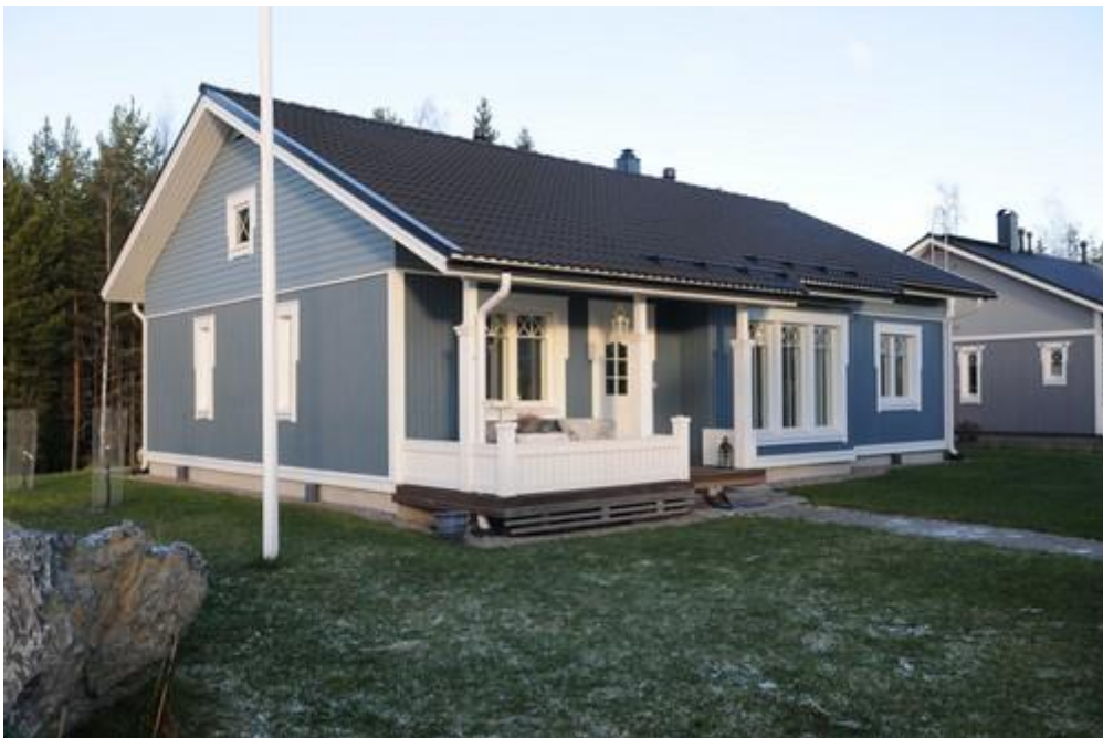
KUVA 12. 2000-luvun perinteinen puutalo (Hänninen 2016)
