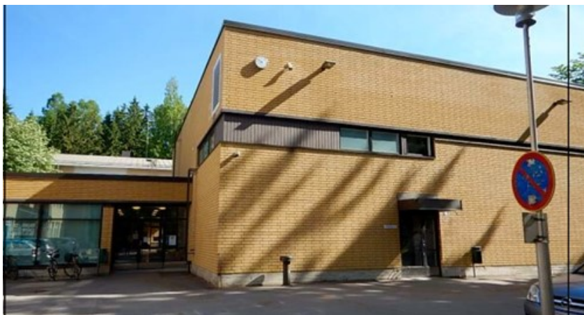
Kuva 3. Korkea laajennusosa on rakennettu matalan laajennuksen kylkeen. Kuva: Tuire Sulka
