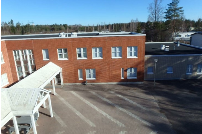
Kuva 8. Länsimäen koulun sisäpiha. Kuva: Sisäilmasto ja kosteustekninen kuntotutkimus Länsimäen koulu 2019
