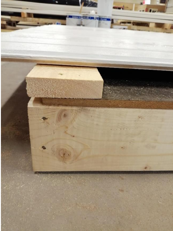
Kuva 27. Varaston etuseinän rakennekerrokset, etuseinä valmis (Sydänmetsä 2020)
