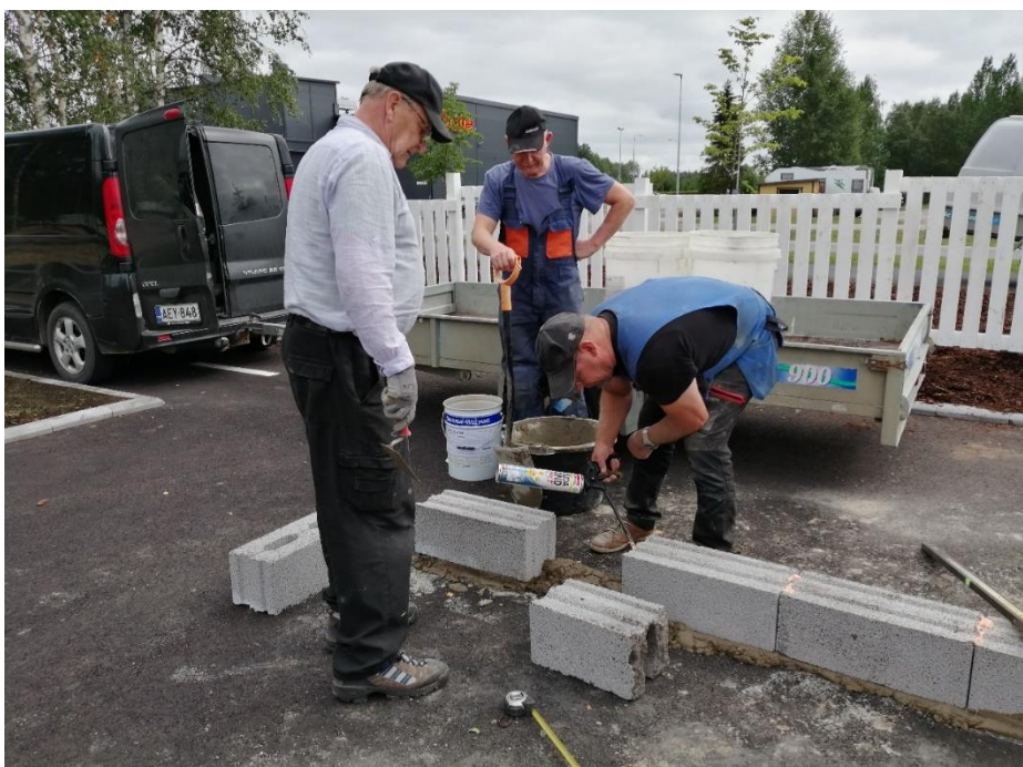
Kuva 41. Varaston sokkelin valmistus (Sydänmetsä 2020)
