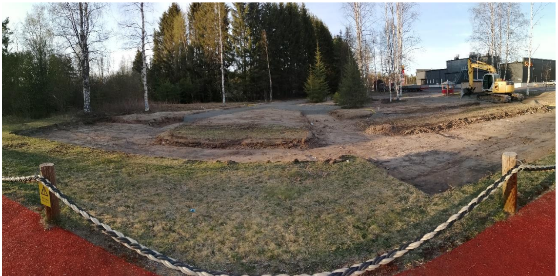
Kuva 12. Ajoväylien kaivuu (Sydänmetsä 2020)
