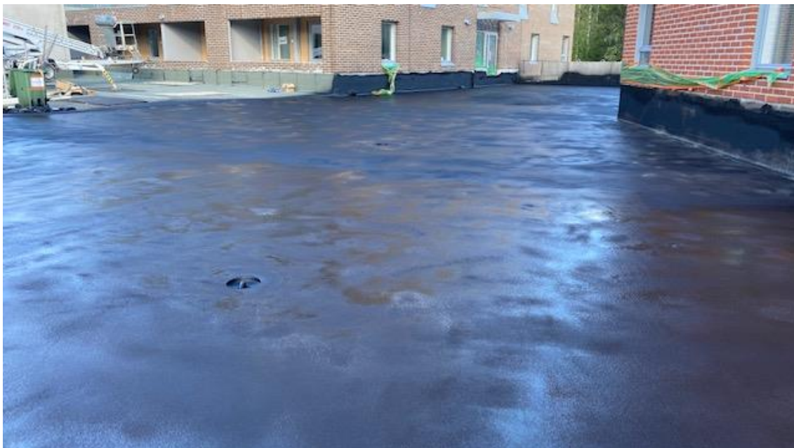
Kuva 10. Ruiskukumilla tehty pihakansi, kuva Ruiskukumi Oy referenssi työmaa
