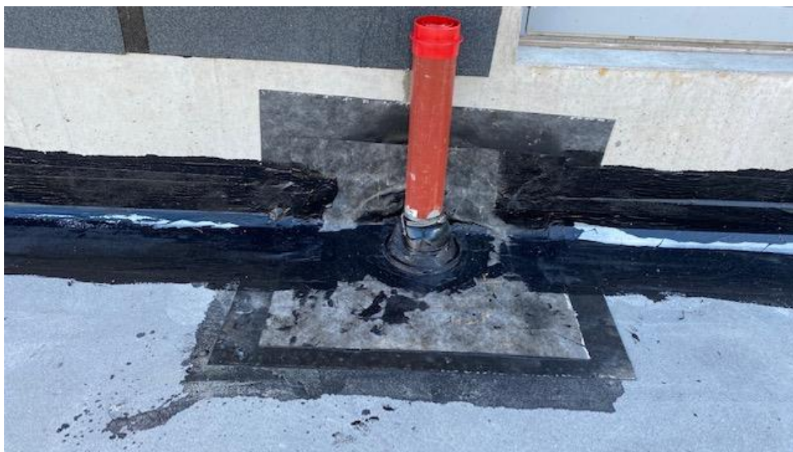
Kuva 12. Ruiskukumi Oy referenssi työmaalta riskirakenteiden ruiskukumiasennusta.
