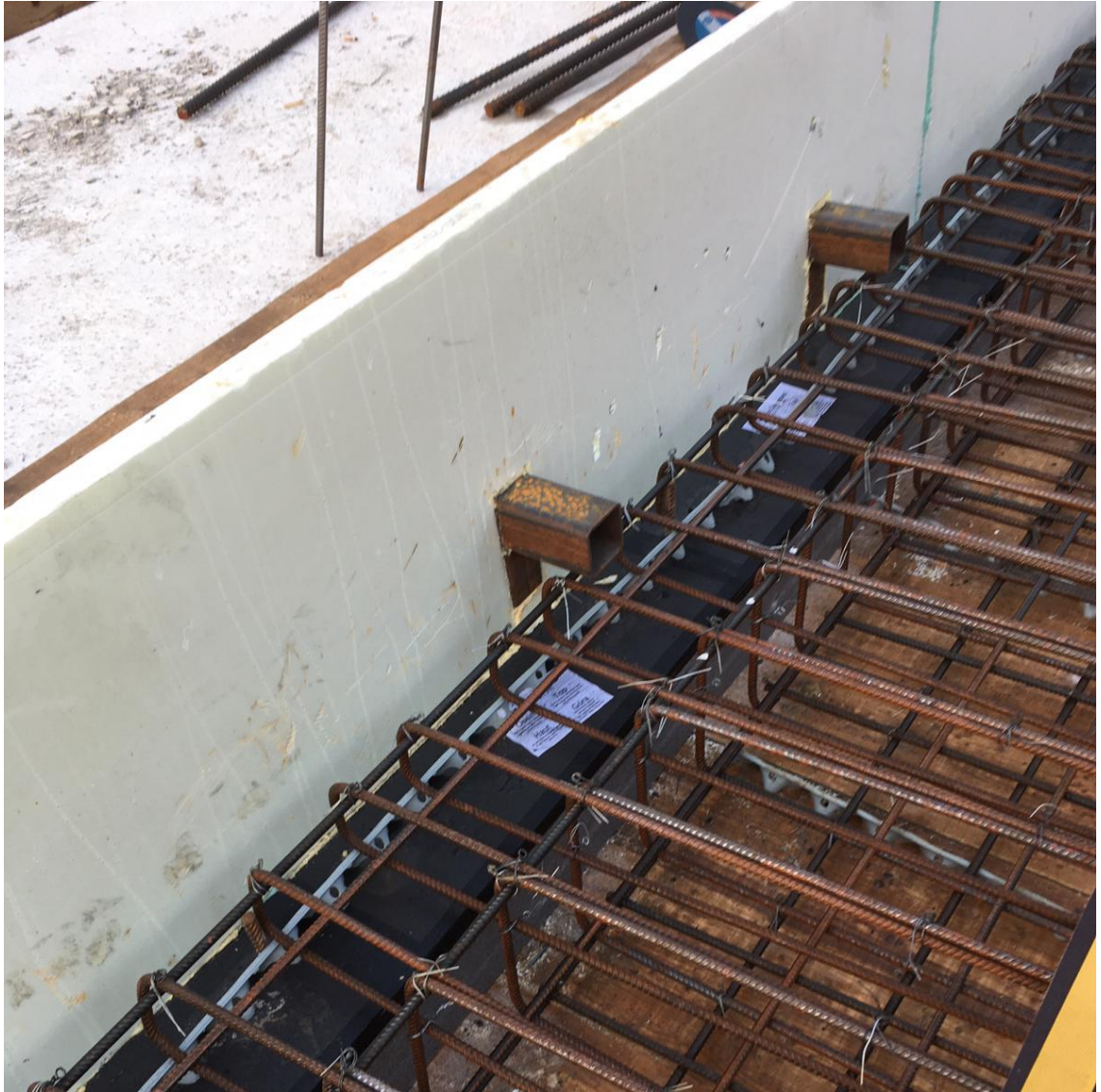
Kuva 5. Liikuntasauaman toisella puolella on jo valettu betonilaatta ja toisella puolella valuvalmisteltu raudoitettu lohko. Saumakohdassa on eriste, joka toimii laakerina laattojen välillä, kuva Linda Melanen.
