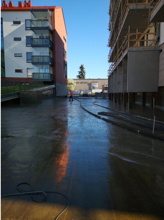
Kuva 13. Lännen Pinnoitetyö Oy:n referenssikuva Porin työmaalta, pinnoitetyö menossa.
