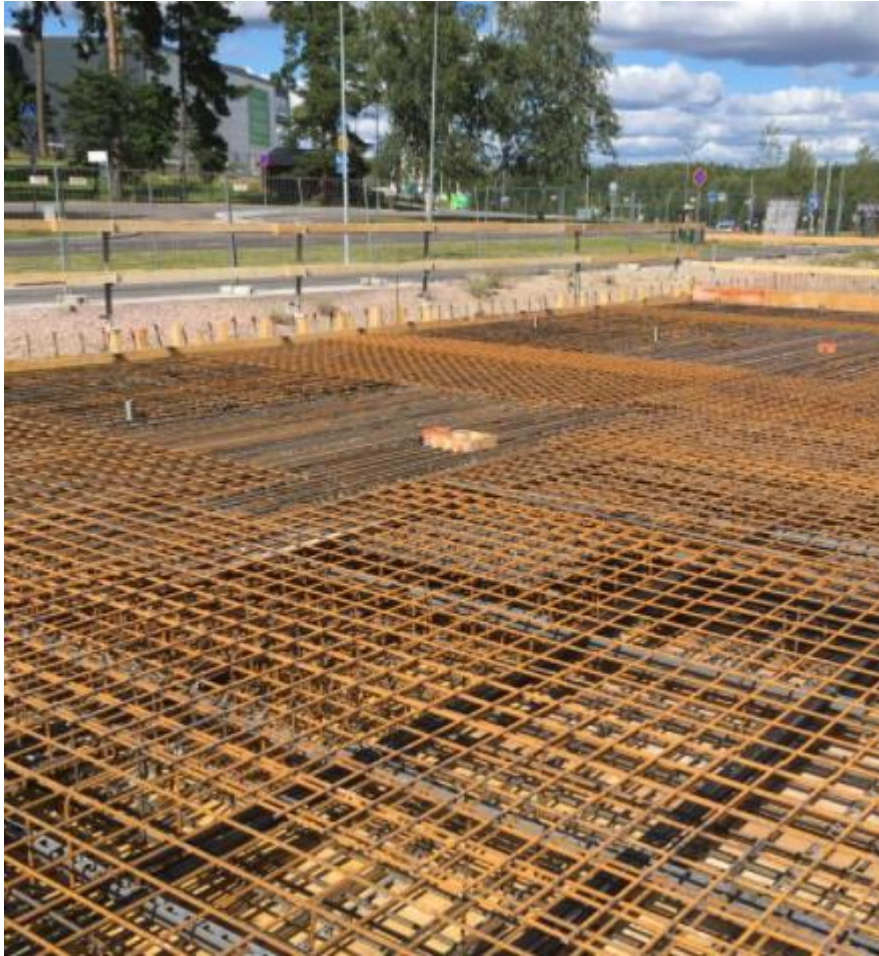
Kuva 2. Jälkijännitetty laatta ennen betonivalua, kuva Linda Melanen.
