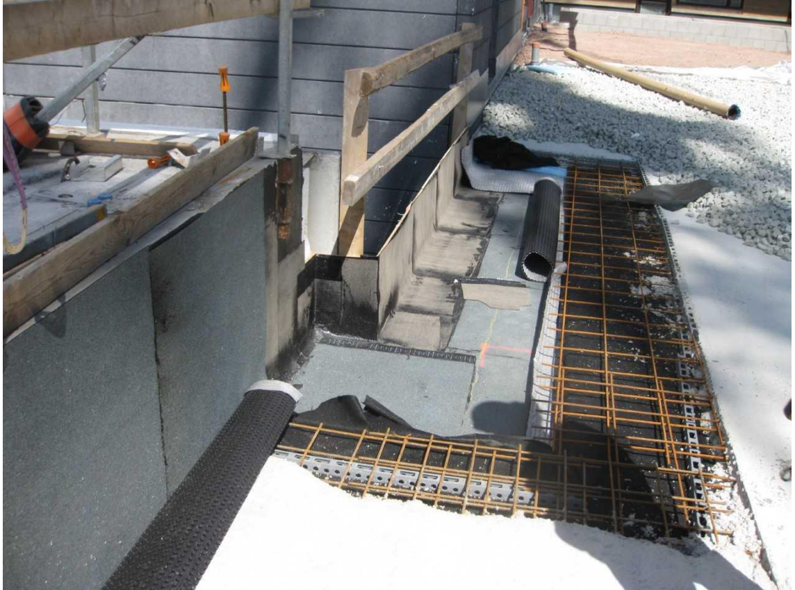
Kuva 7. Ruuffi Oy:n referenssikuva työmaalta. Kuvassa näkyy hyvin kaikki kerrokset.
