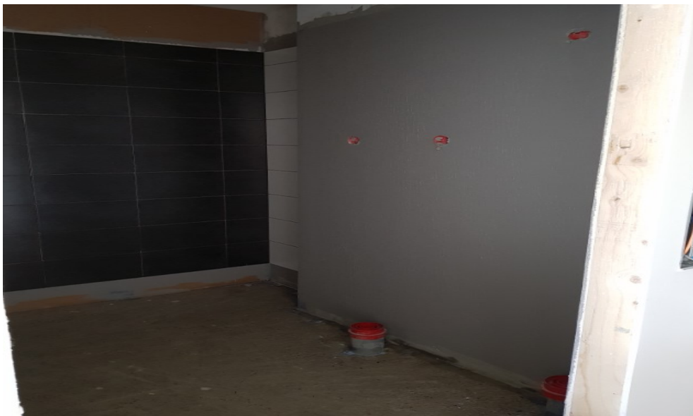
KUVA 7. Edessä oikealla vesieristetty seinä ja takana vasemmalla laatoitettu seinä
