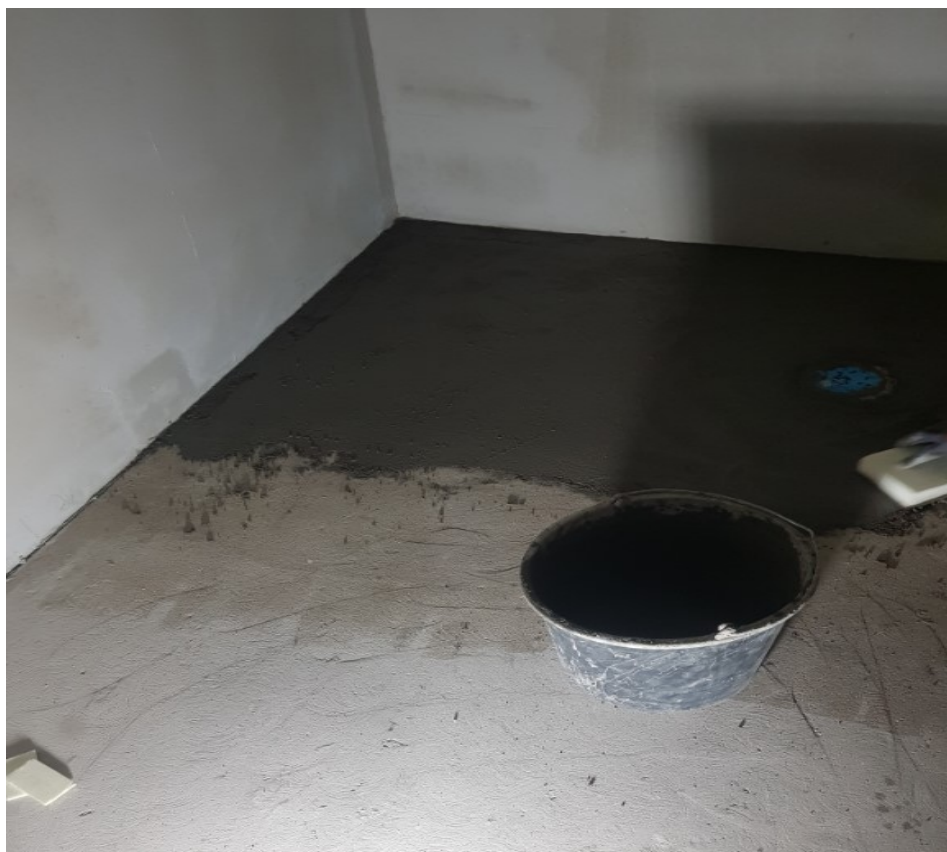
KUVA 4. Lattian kaatokorjauksien tekoa paikallavalun jälkeen
