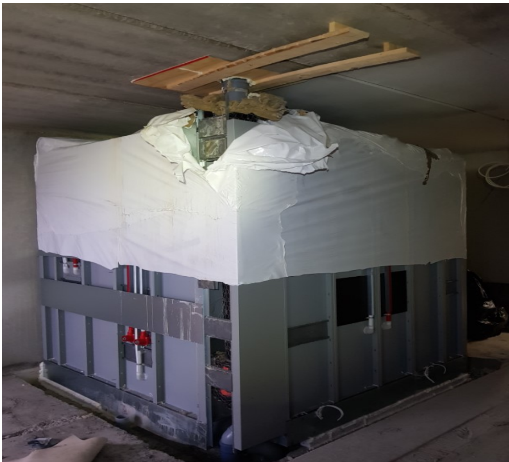
KUVA 12. Kylpyhuone-elementin tukkeiden tekoa
