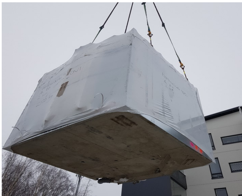
KUVA 10. Kylpyhuone-elementin nosto asennussyvennykseen. Viemärin betonoitu äänenvaimennin näkyy laatan pohjassa
