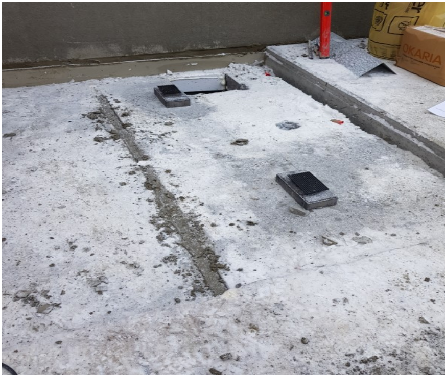
KUVA 9. Asennussyvennyks kololaatassa, jossa on kumiset asennuspalat vaaittuna oikeaan korkoon
