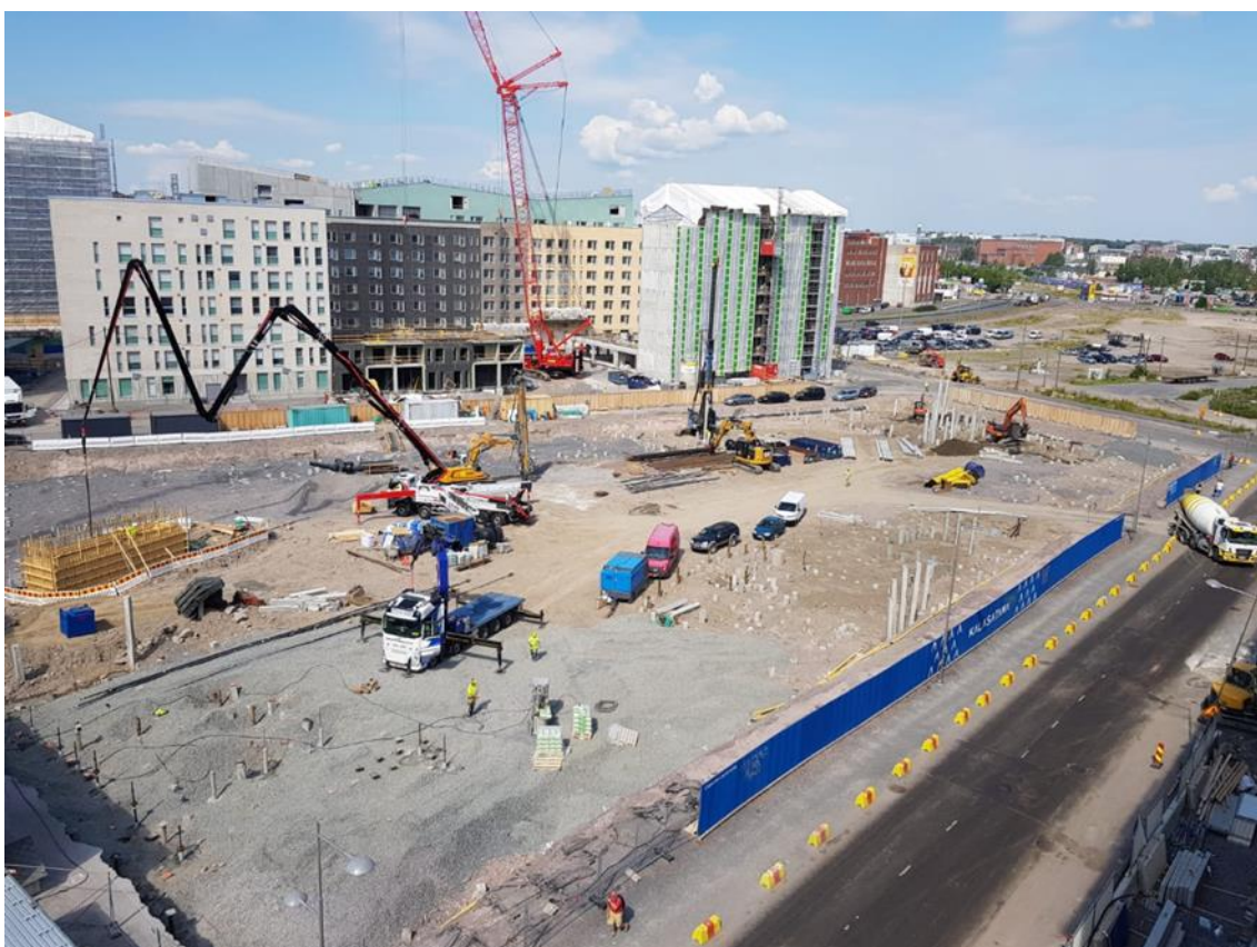
Kuva 7. Maarakennusvaiheen kalustoa työmaalla.
