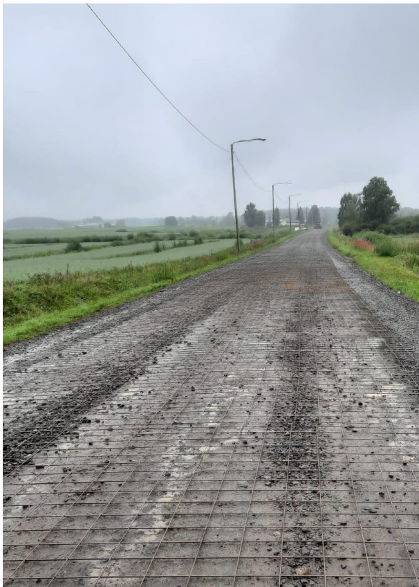
KUVA 3. Sekoitusjyrsityn kerroksen päälle asennetut teräsverkot ennen niiden peittämistä murskeella
