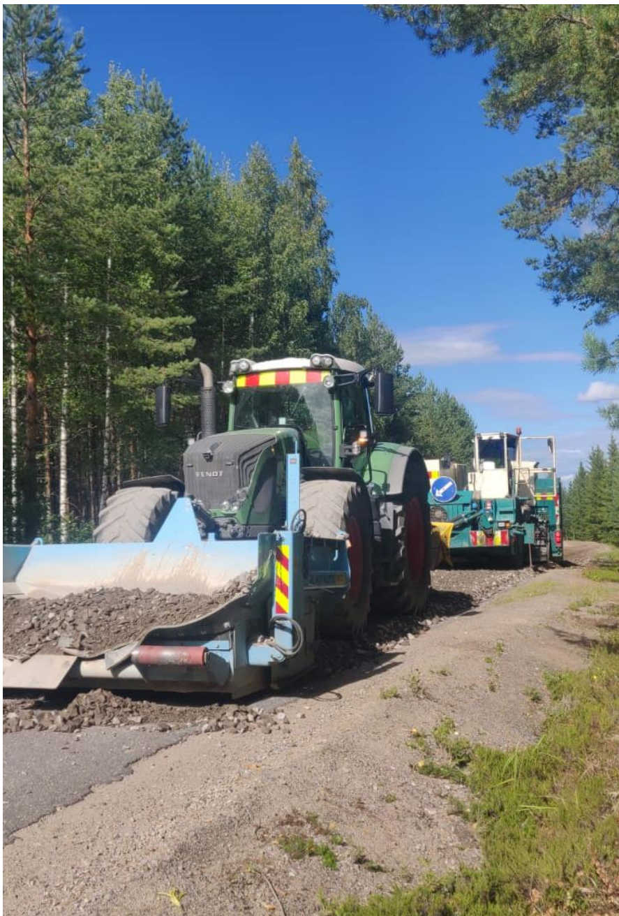
KUVA 5. Lisämurskeenlevitys menossa sekoitusjyrsittävän päällysteen päälle
