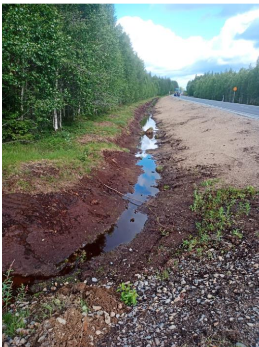
KUVA 4. Juuri ennallistettu sivuoja turvepohjaisella alueella
