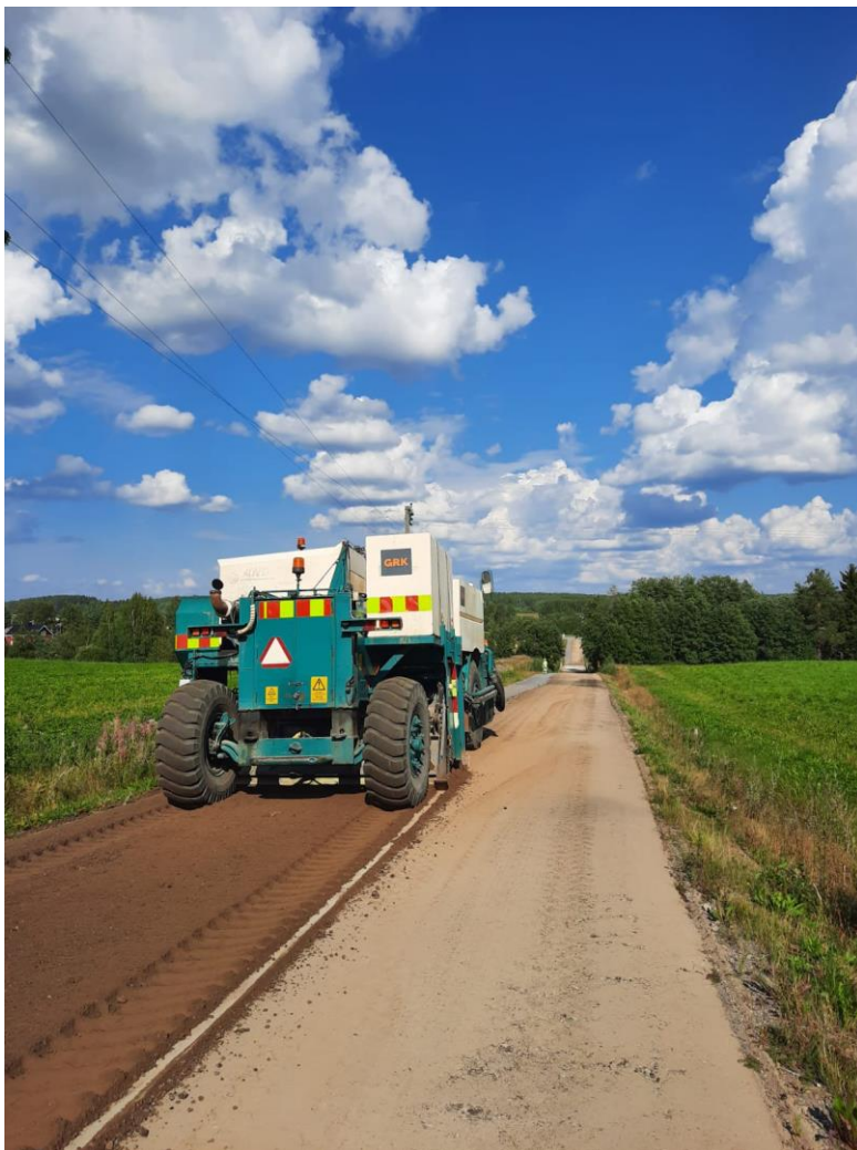
KUVA 2. 4200-stabilointi- ja sekoitusjyrä.
