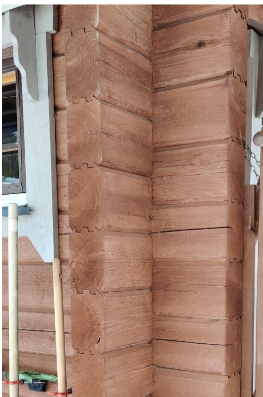
Kuva 8. Lamellihirret läheltä.
