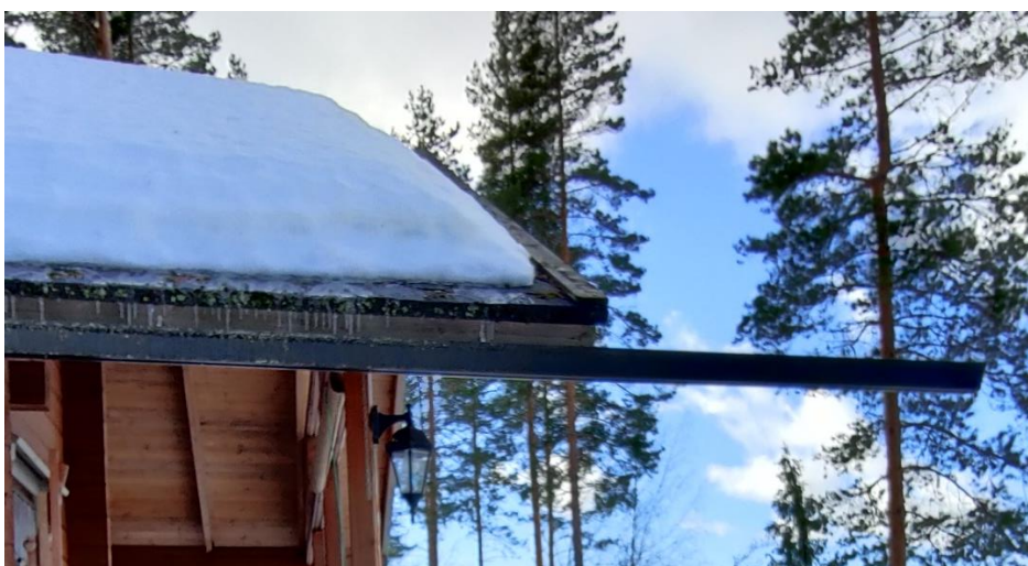
Kuva 10. Räystäskouru.
