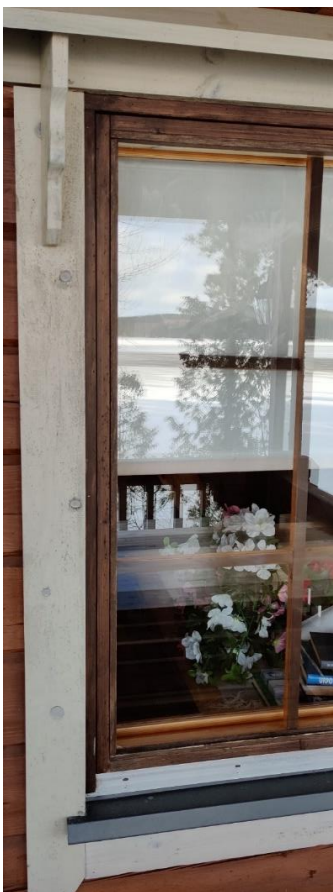
Kuva 18. Verannan alla oleva ikkuna.
