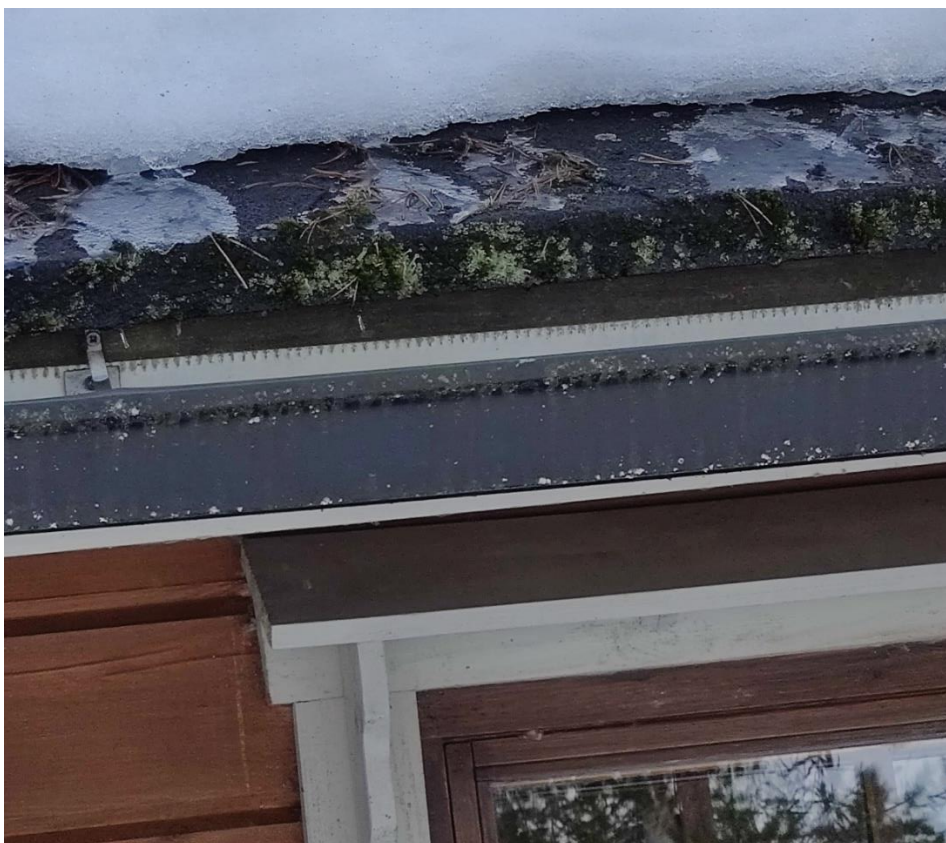
Kuva 26. Huopakatteen päällä kasvaa paikoin sammalta
