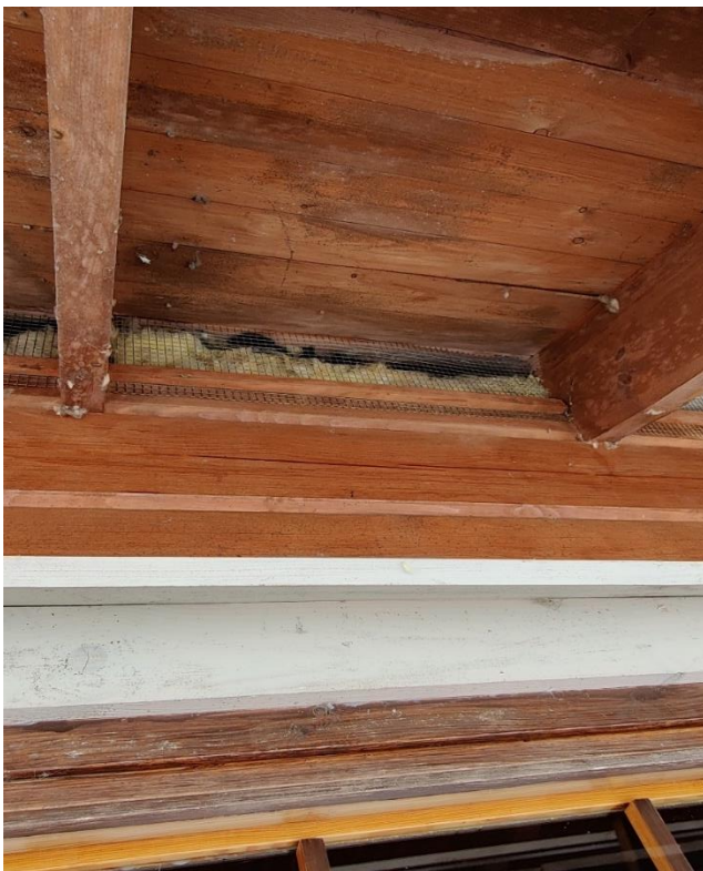
Kuva 23. Idän julkisivun räystäään pieneläinverkko/tuuletusaukko.
