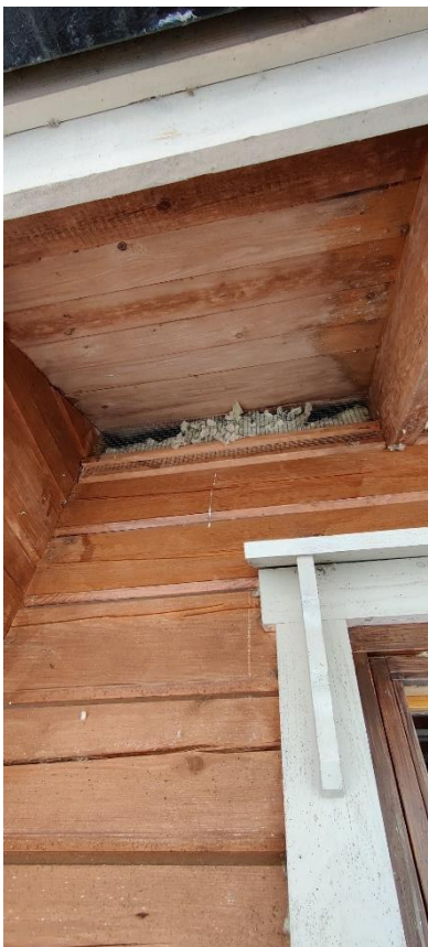
Kuva 22. Idän julkisivun räystäään pieneläinverkko/tuuletusaukko.
