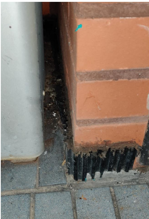
Kuva 33. Kiukaan takana oleva valukaulus on osittain irronnut.
