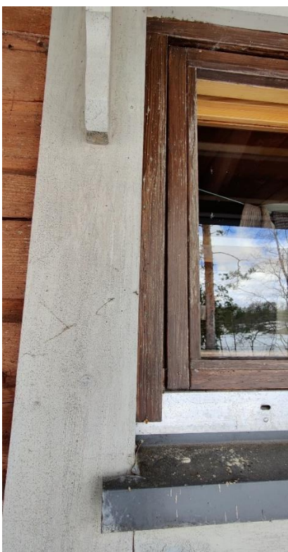
Kuva 19. Idän puolella oleva saunan ikkuna.
