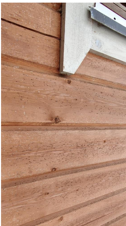
Kuva 6. Lähikuva idän julkisivun kunnosta.
