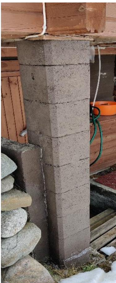
Kuva 2. Harkkopilari.
