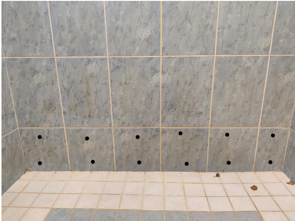
Pesuhuoneen seinästä mitatut pisteet
