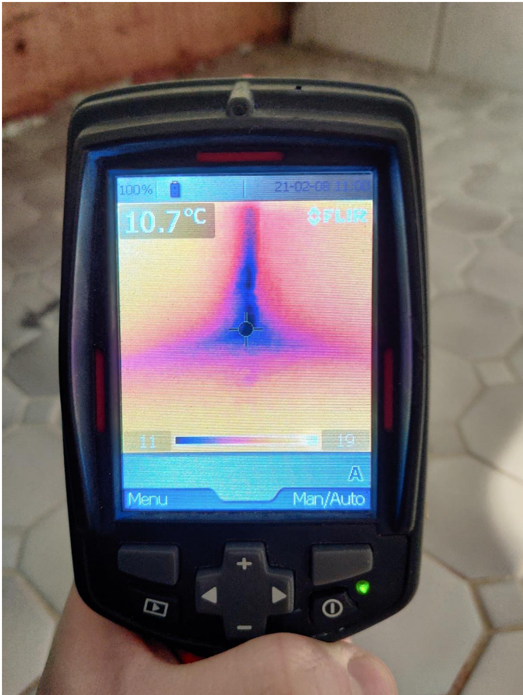
WC:n ulkoseinän vastainen alanurkka
