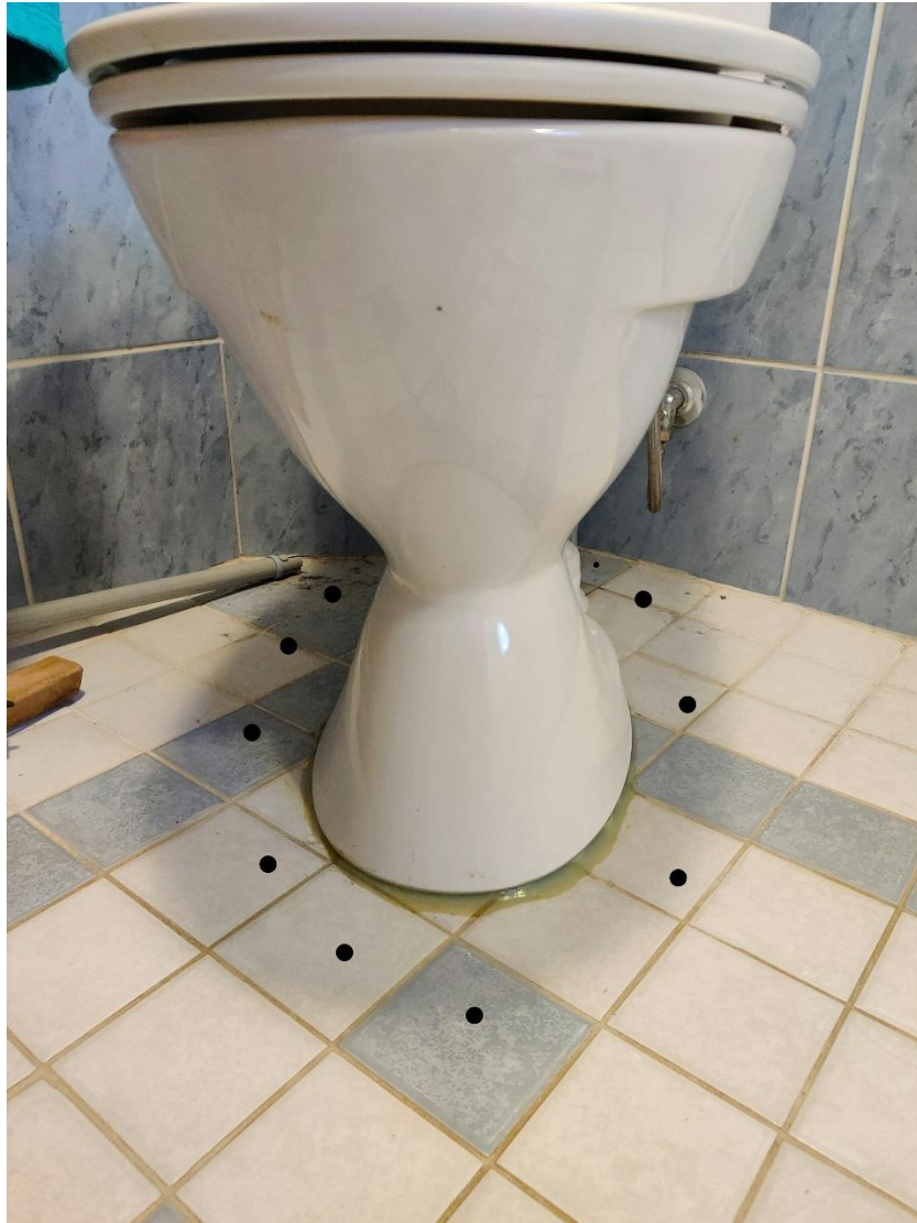
Pesuhuoneen WC-istuimen ympärystän mittauspisteet
