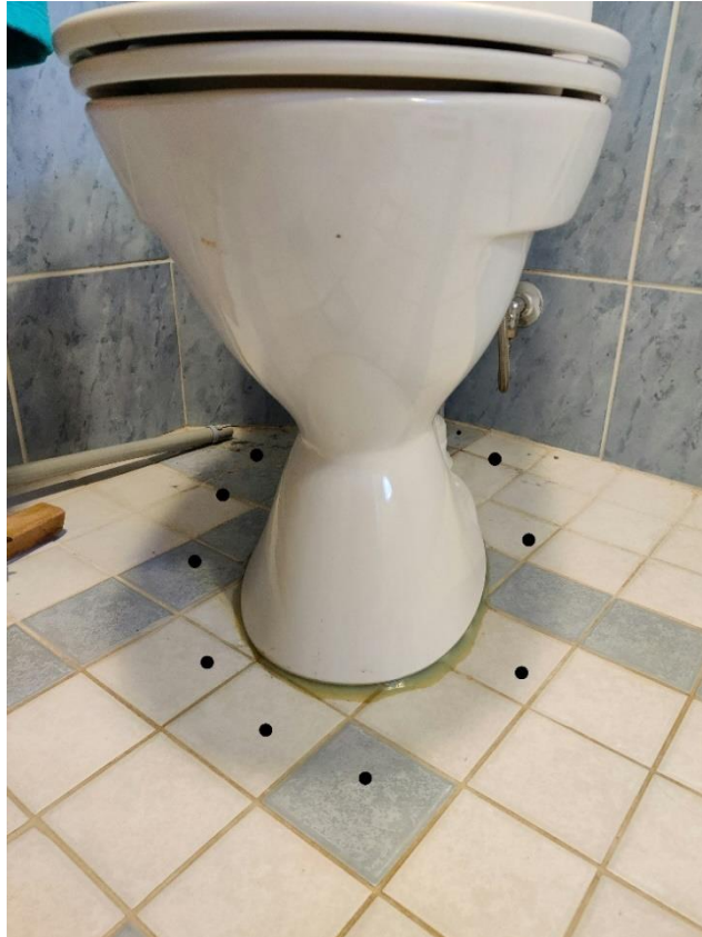
Kuva 5. WC-istuimen pintakosteusmittaus kohdat
