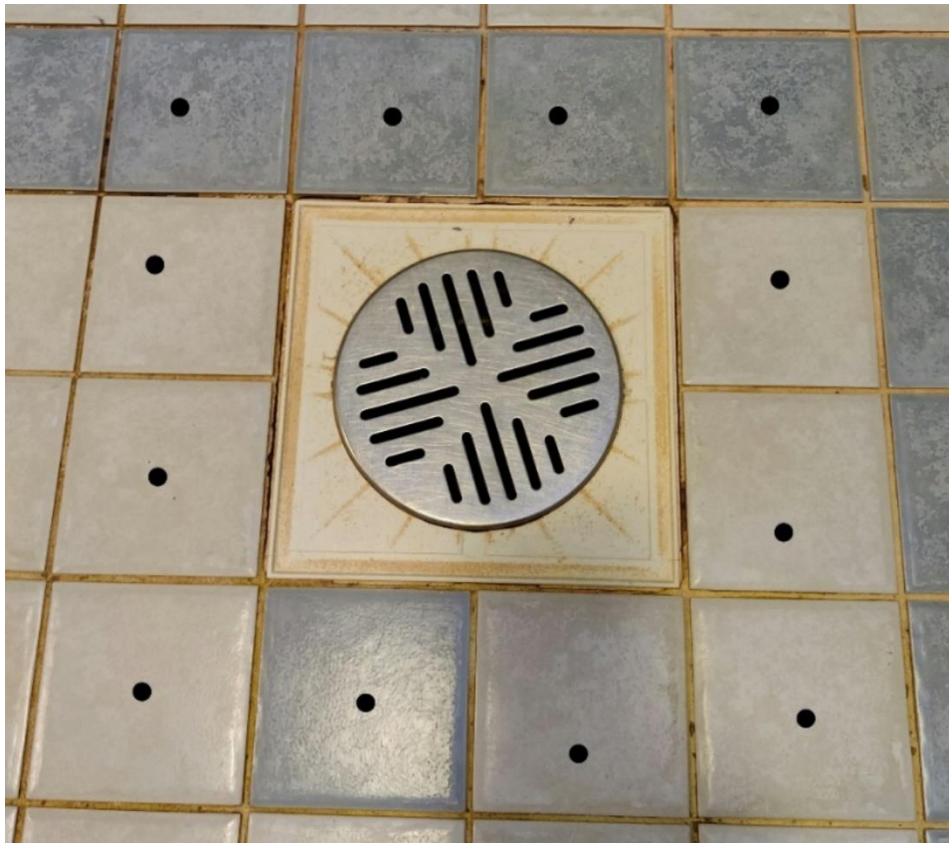
Kuva 6. Pesuhuoneen lattiakaivon ympäryslaattojen pintakosteusmittauspisteet
