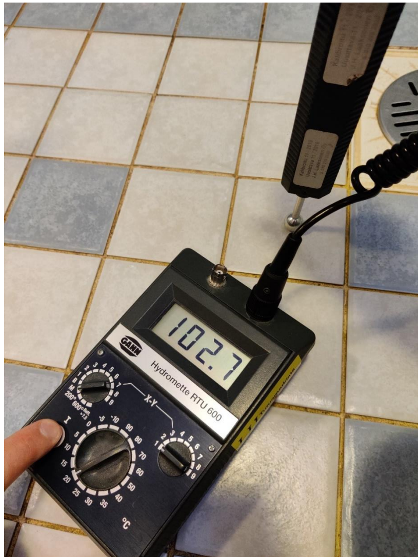
Kuva 7. Pesuhuoneen lattiakaivon ympäröivien laattojen pintakosteusmittausta
