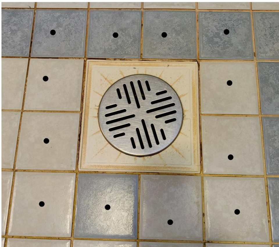
Pesuhuoneen lattiakaivon ympärystän pintakosteusmittauspisteet
