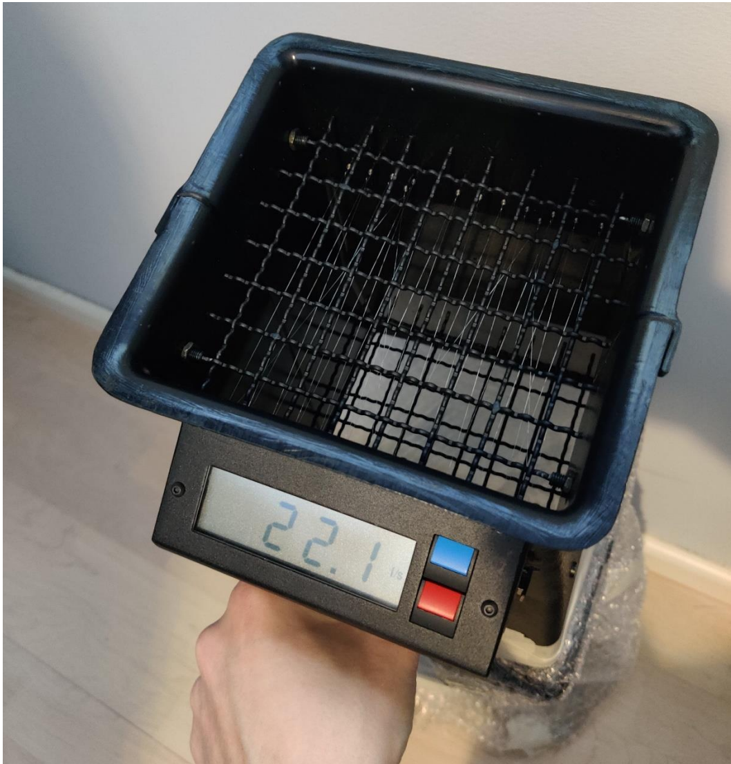
Lastenhuoneen tuloilman mittaus
