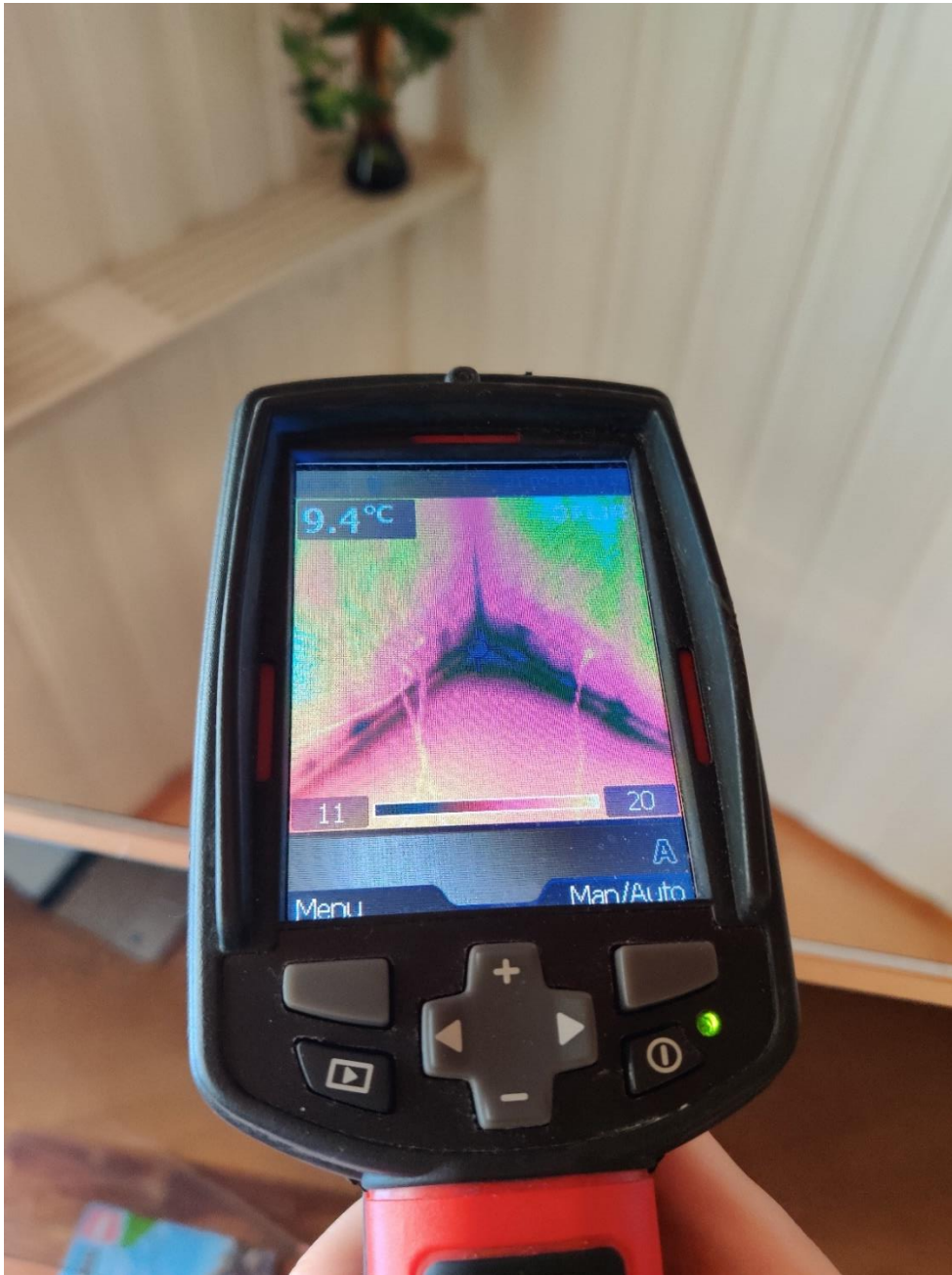
Olohuoneen toinen ulkoseinä nurkka
