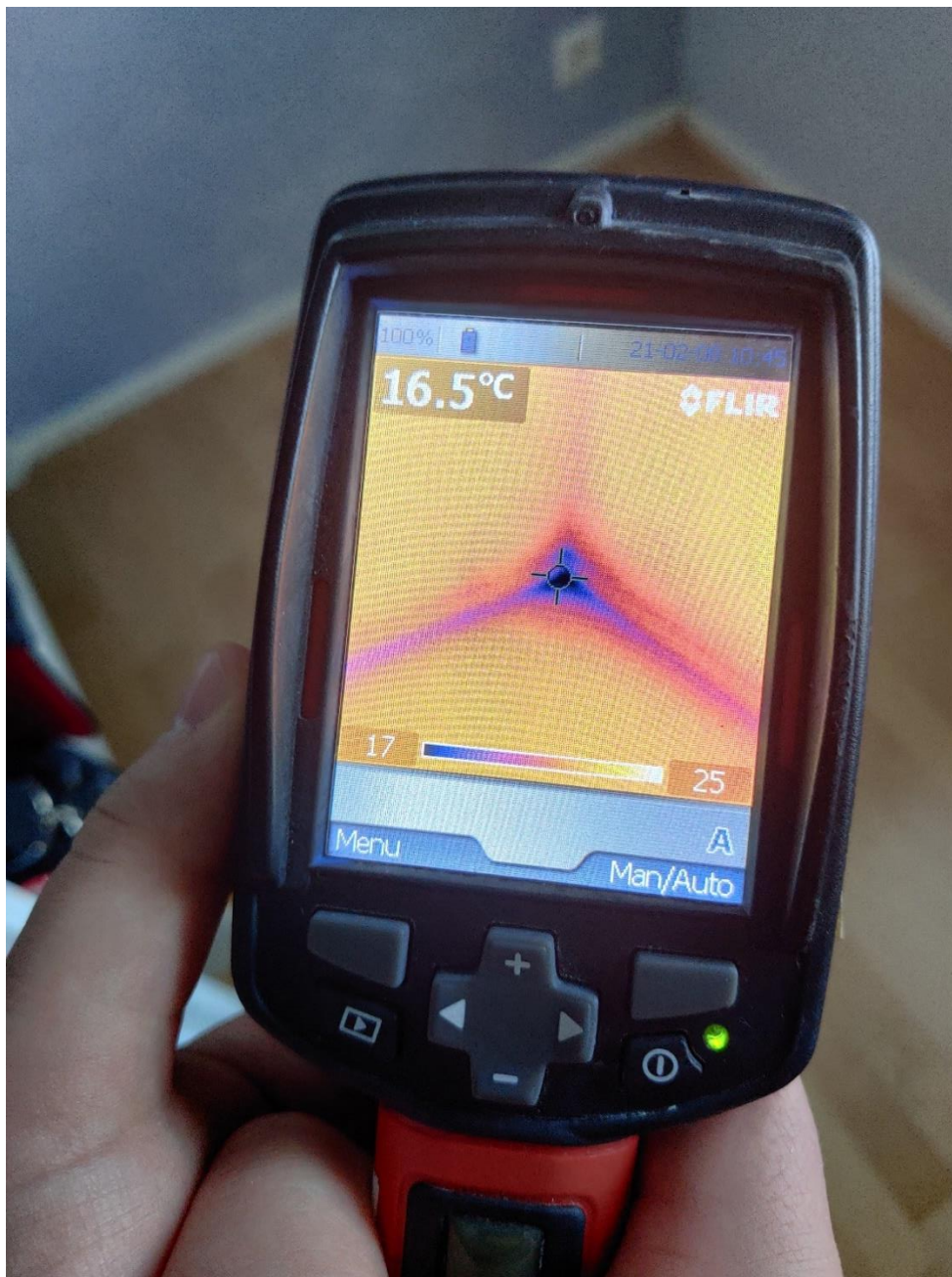
Lastenhuoneen ulkoseinä nurkan alalaita
