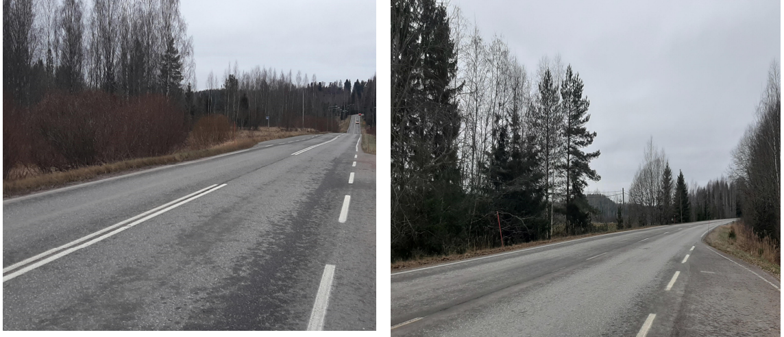
Kuva 9. Vasemmanpuoleisessa kuvassa on tienpinnalle edellisenä iltana (2.12.2020) levitetty Natriumkloridia ja oikeanpuoleisessa kuvassa kierrätysuolaliuosta.
