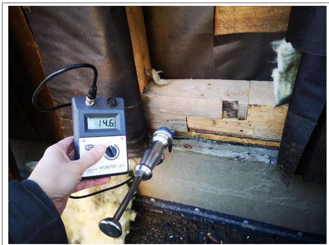
Kuva 14. Ulkoseinän puurakenteiden kosteustila mitattiin piikkimittarilla. Mittauksessa rakenteet todettiin kuiviksi. (Minkkinen 2020)
