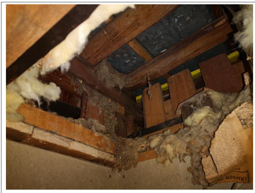
Kuva 13. Talousrakennuksen yläpohjaan tehtiin rakenneavaus rakenteiden varmistamiseksi. (Minkkinen 2020)
