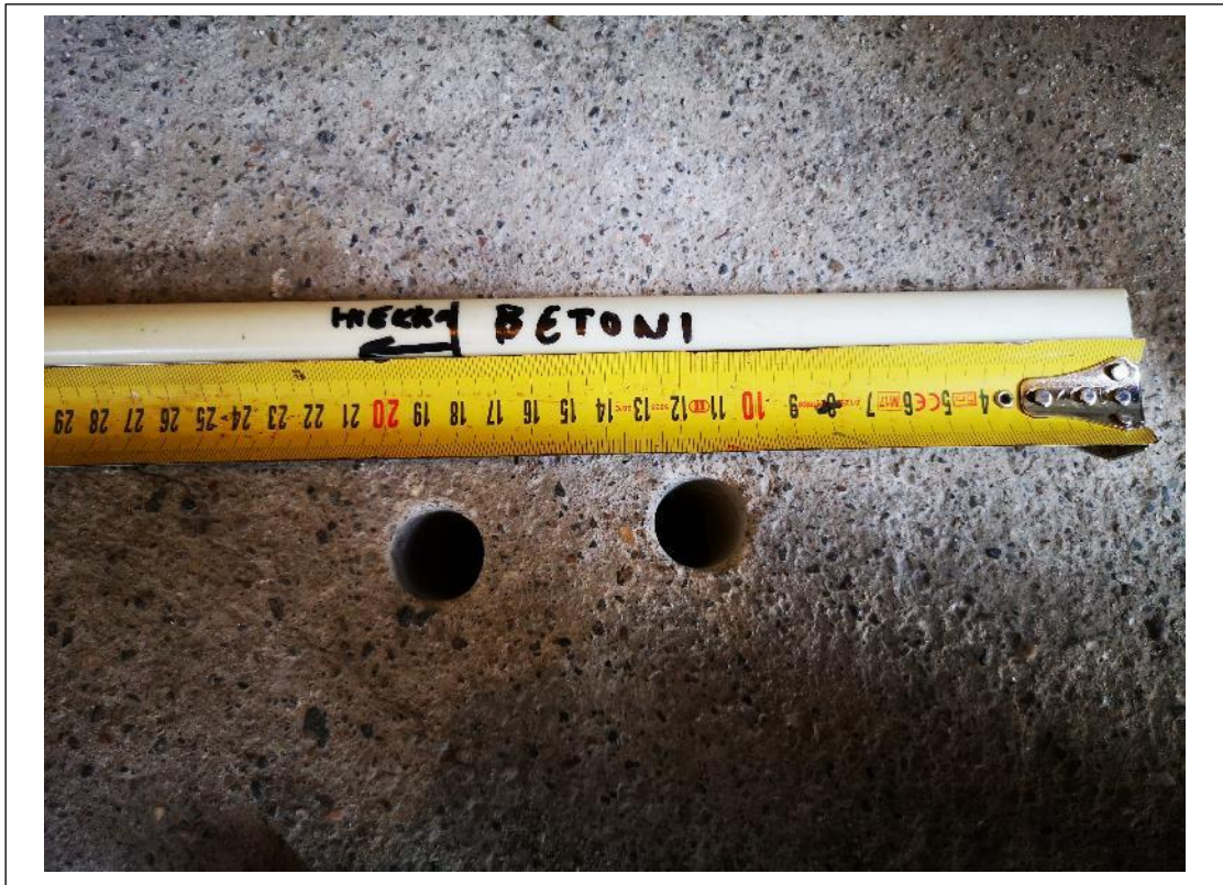
Kuva 15. Alapohjan rakenne varmistettiin poraamalla sen läpi 25 mm reikä. (Minkkinen 2020)
