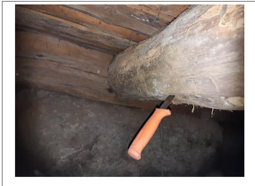
Kuva 6. Kuvassa kantavan puurakenteen sidosaineet ovat hajonneet 1/2 osuudelta puusta pitkän kosteusrasituksen seurauksena. (Minkinen 2019)
