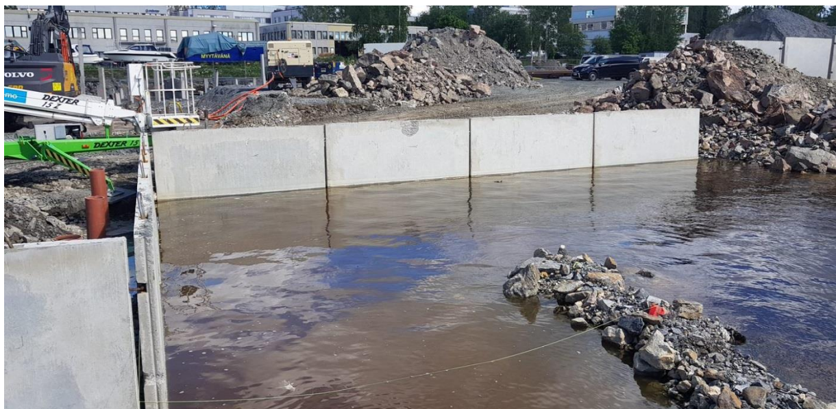
KUVA 10 Kesäistä rakentamista 2019 (Laitinen 2019)
