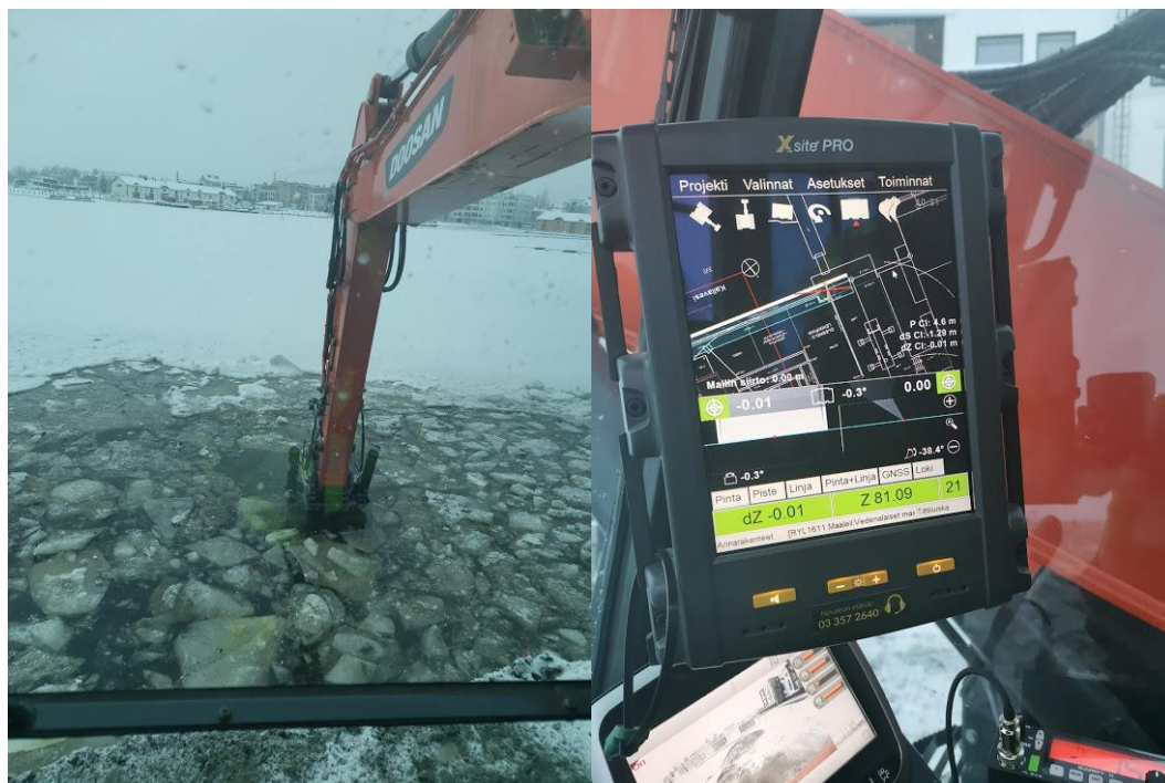
KUVA 5 Arinan tekoa 3D-koneohjauksessa (Tuovinen 2021)
