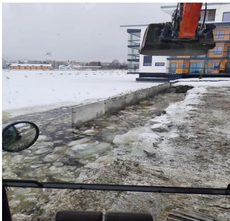
KUVA 6 Elementtien asentamista (Eskelinen 2021)
