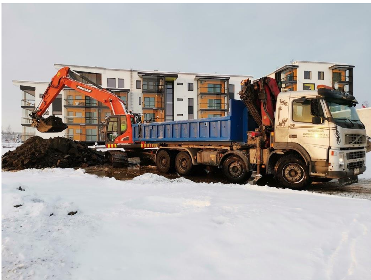
KUVA 4 Ylijäämälouheen kuormausta (Tuovinen 2021)
