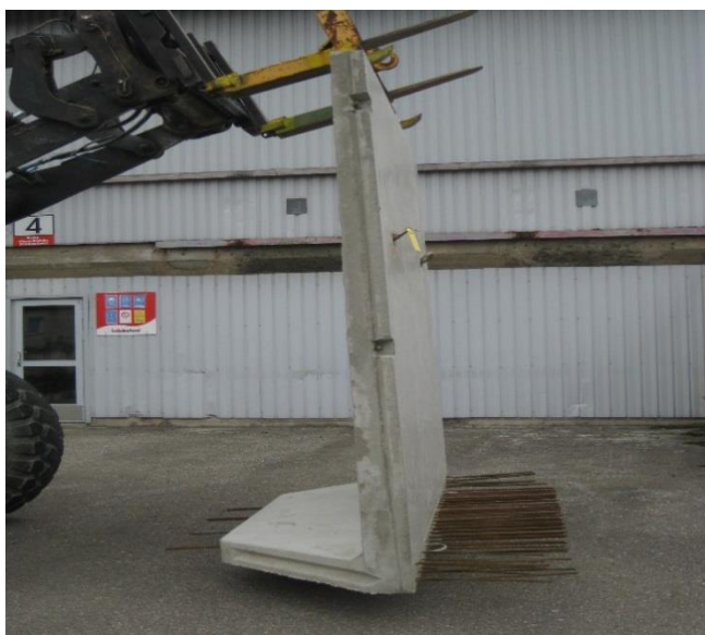
KUVA 2 Tukimuurielementti ennen lisävalua (Laitinen 2019)
