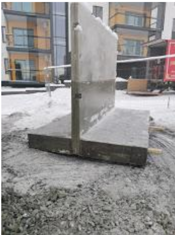
KUVA 3 Lisävalu tehty (Tuovinen 2021)
