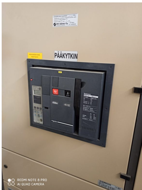
KUVA 7. Sähköpääkeskuksen pääkatkaisija
