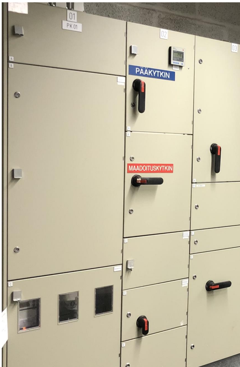
KUVA 6. Sähkökeskuksen merkinnät
