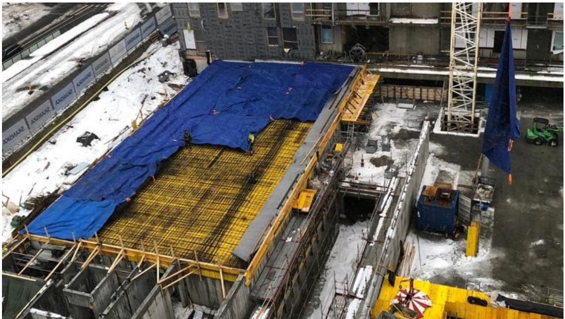
Kuva 5. Holviraudoituksen suojaamista lumipeitteillä työn päätteeksi. Kuva: Petri Kupias
