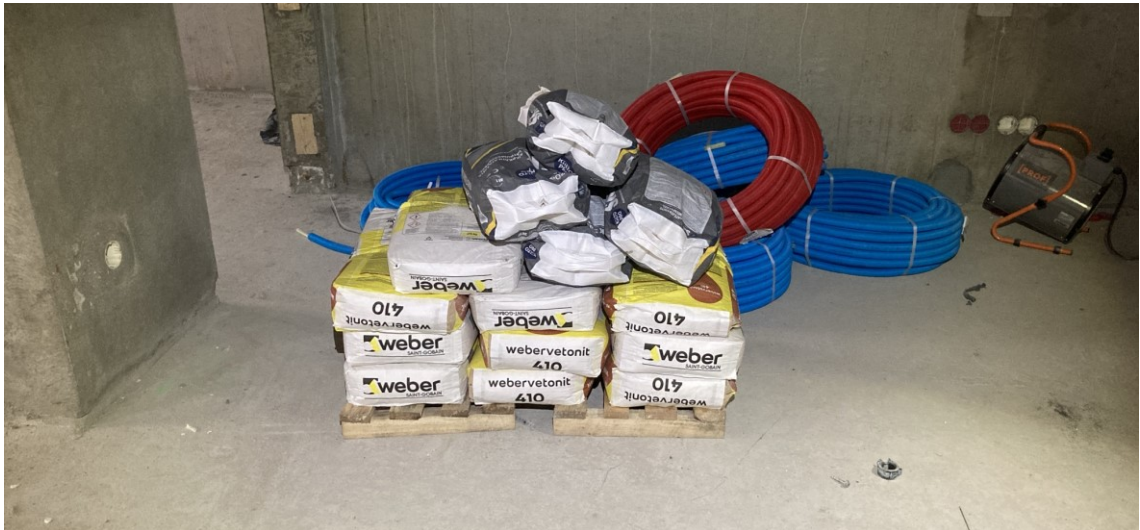
Kuva 8. Aluspuiden päälle varastoituja laastisäkkejä Kuva: Veera Ahlroos
